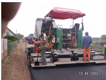
Pierwsza warstwa asfaltu
