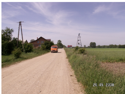
Tuż przed przebudową
