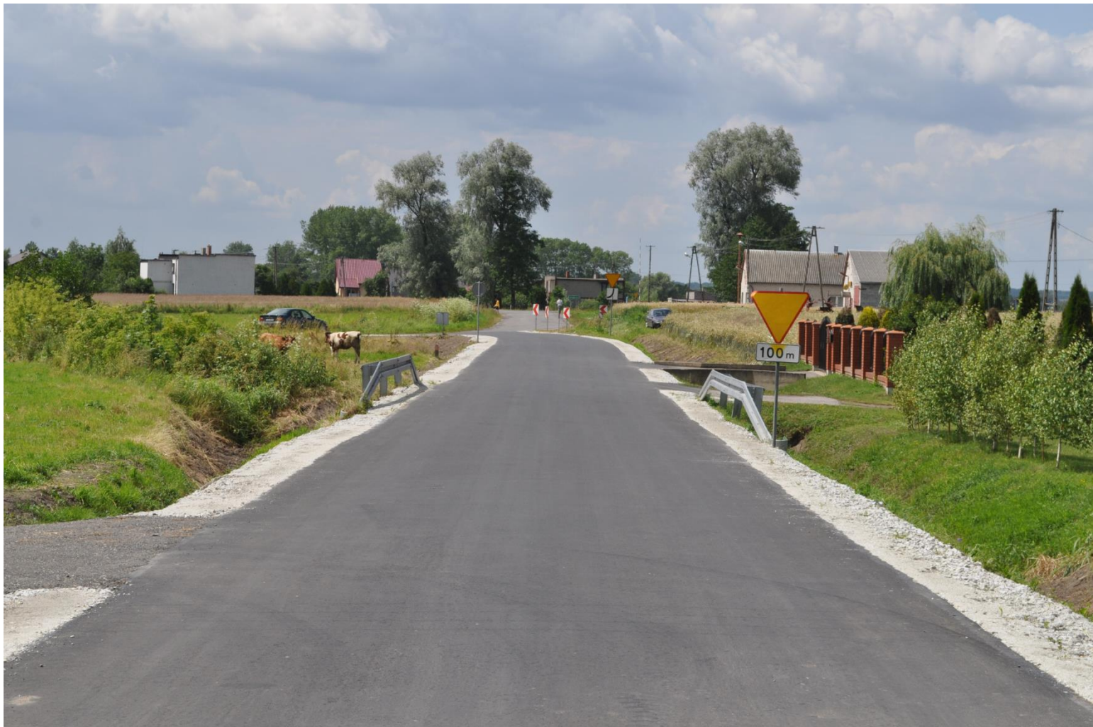
Remont drogi gminnej w miejscowości Ponętów Dolny
