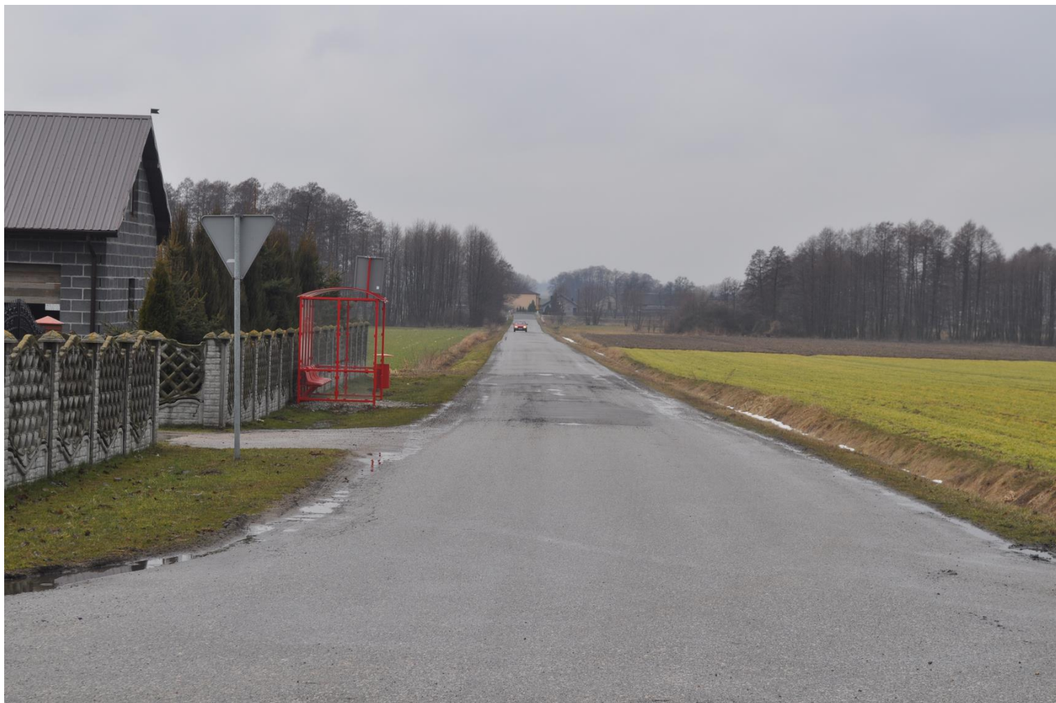
Remont drogi gminnej w miejscowości Zabłocie
