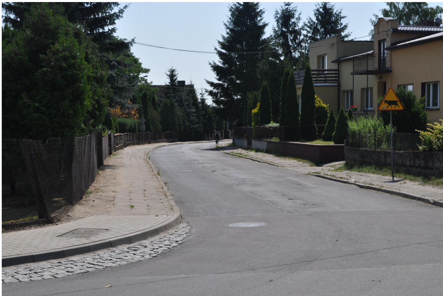
Przebudowa ulicy Leśnej
