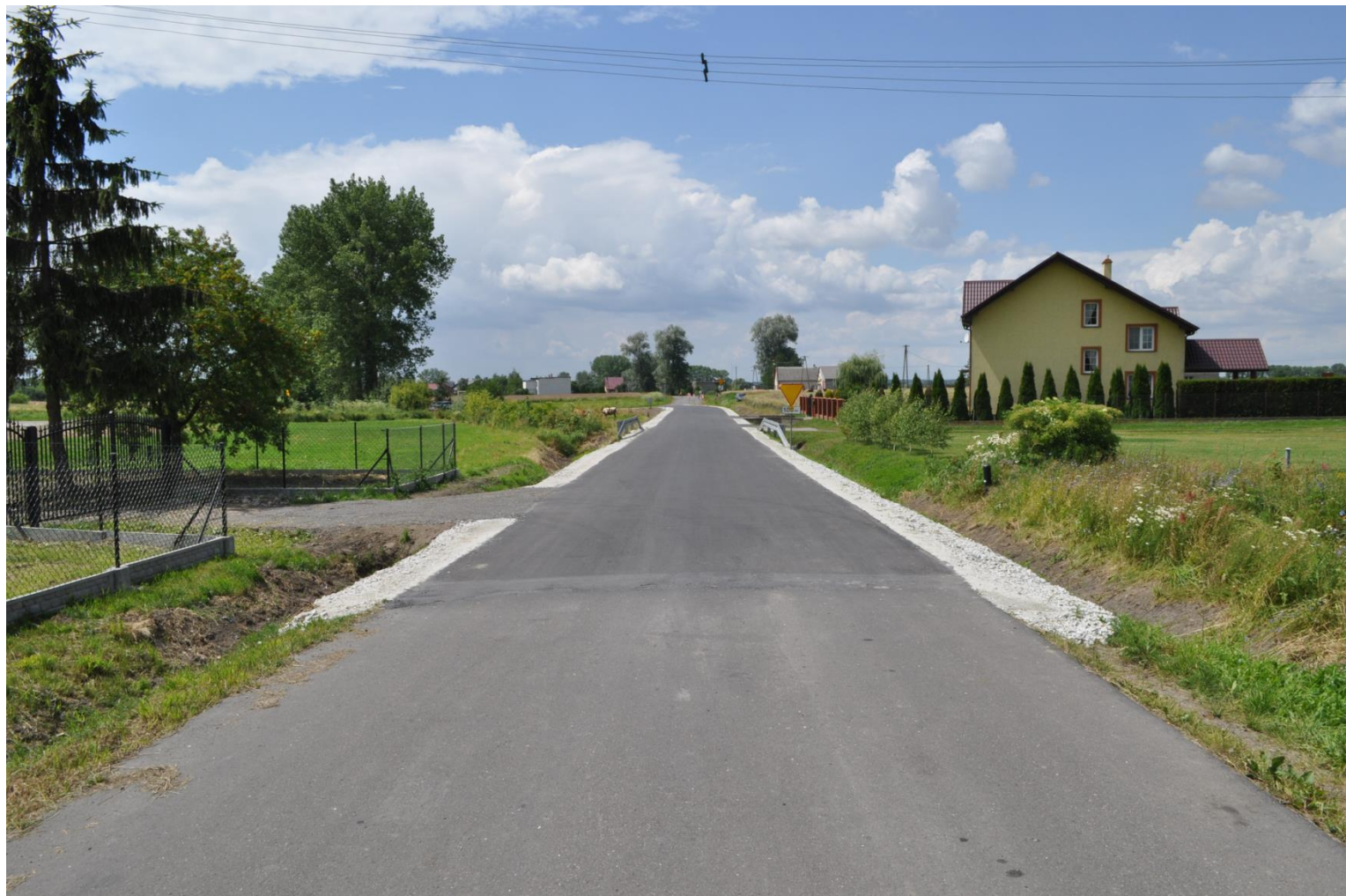
Remont drogi gminnej w miejscowości Ponętów Dolny
