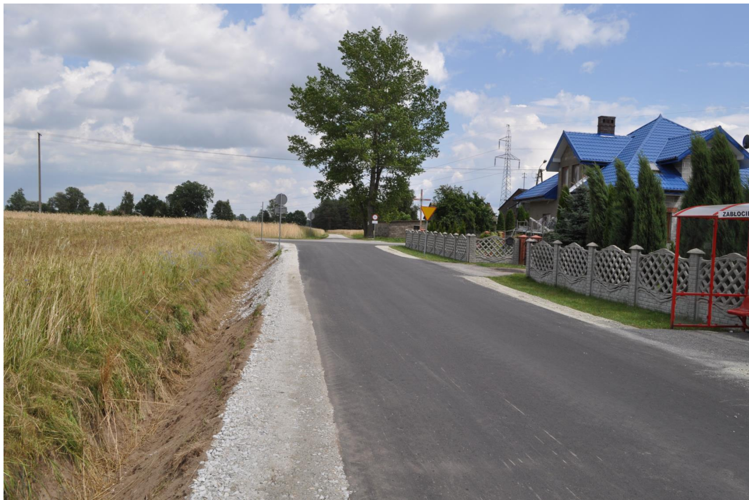
Remont drogi gminnej w miejscowości Zabłocie
