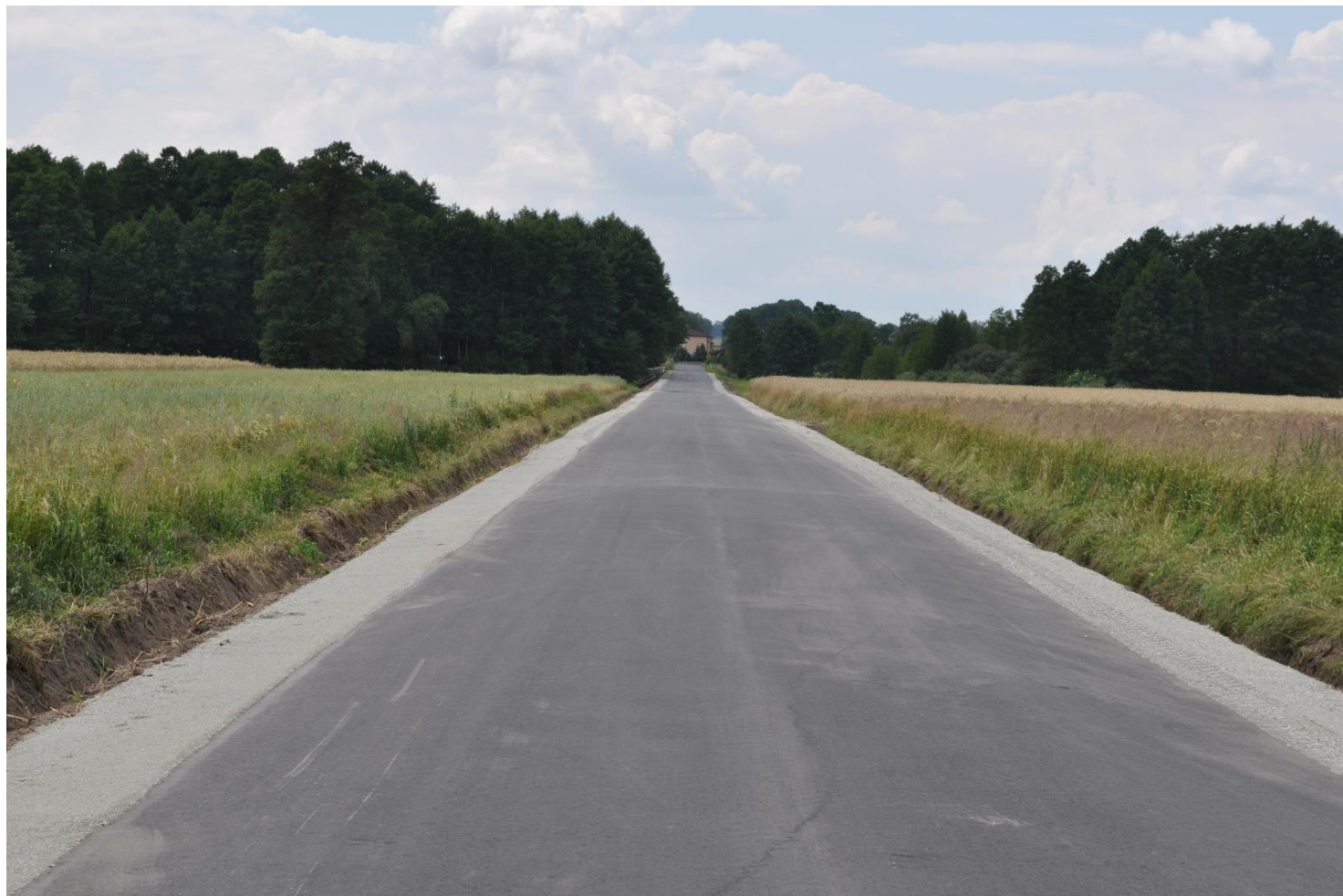
Remont drogi gminnej w miejscowości Zabłocie
