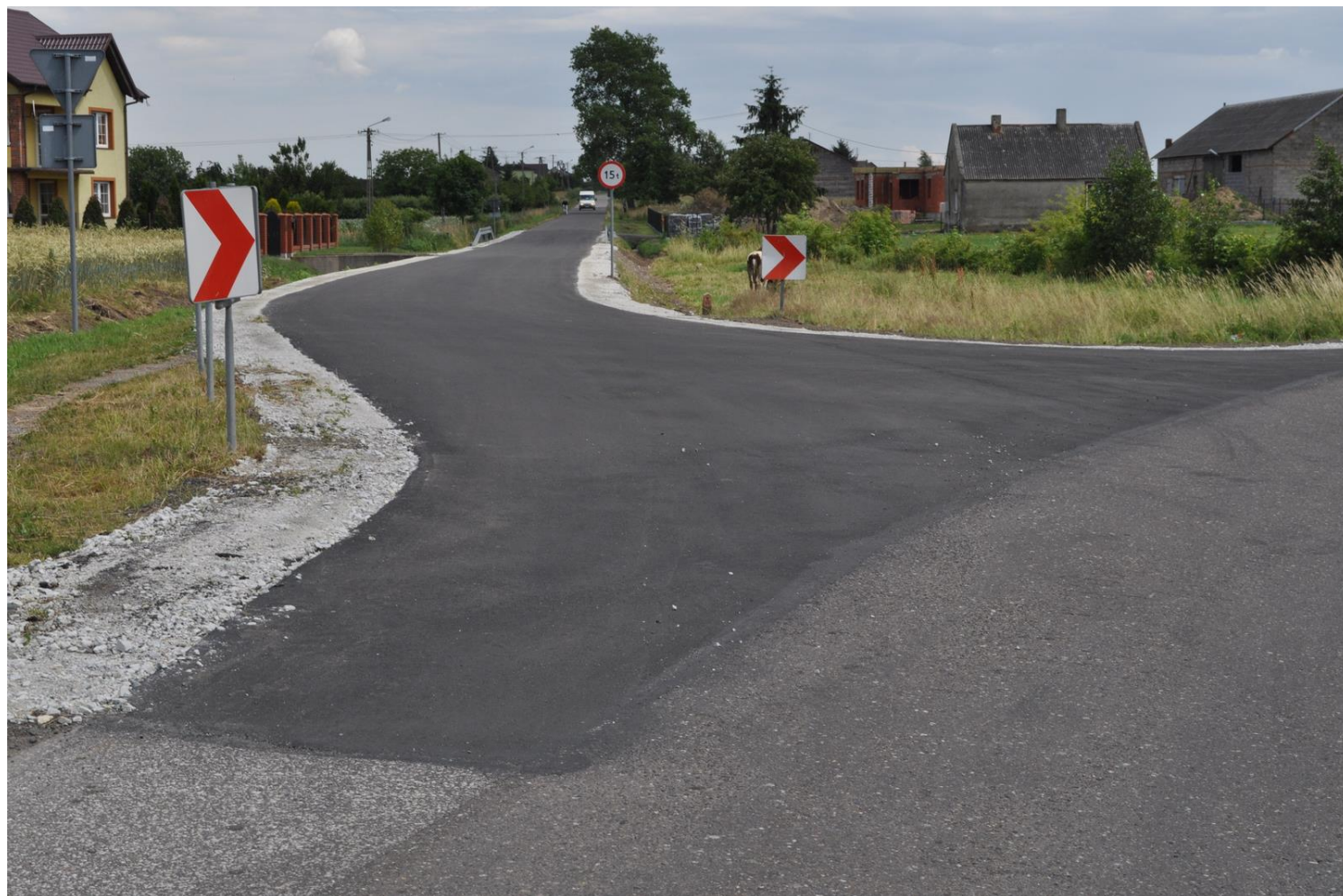
Remont drogi gminnej w miejscowości Ponętów Dolny
