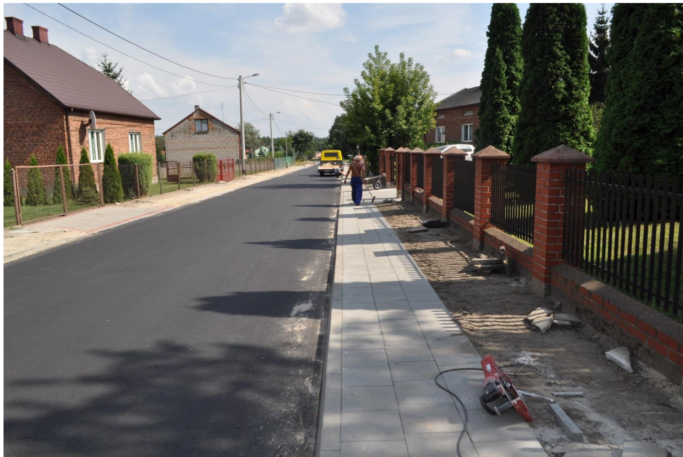
Przebudowa ulicy Leśnej
