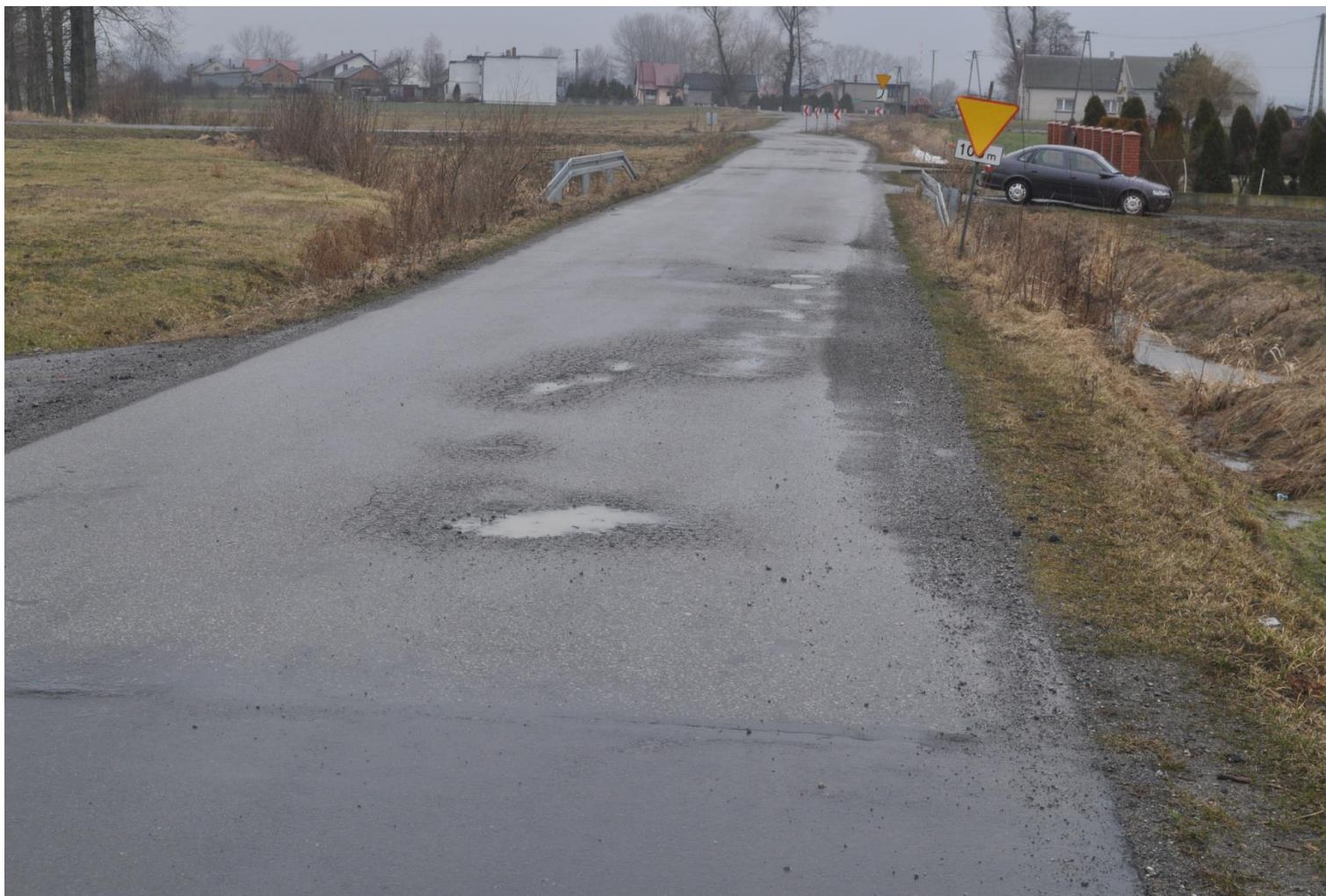
Remont drogi gminnej w miejscowości Ponętów Dolny
