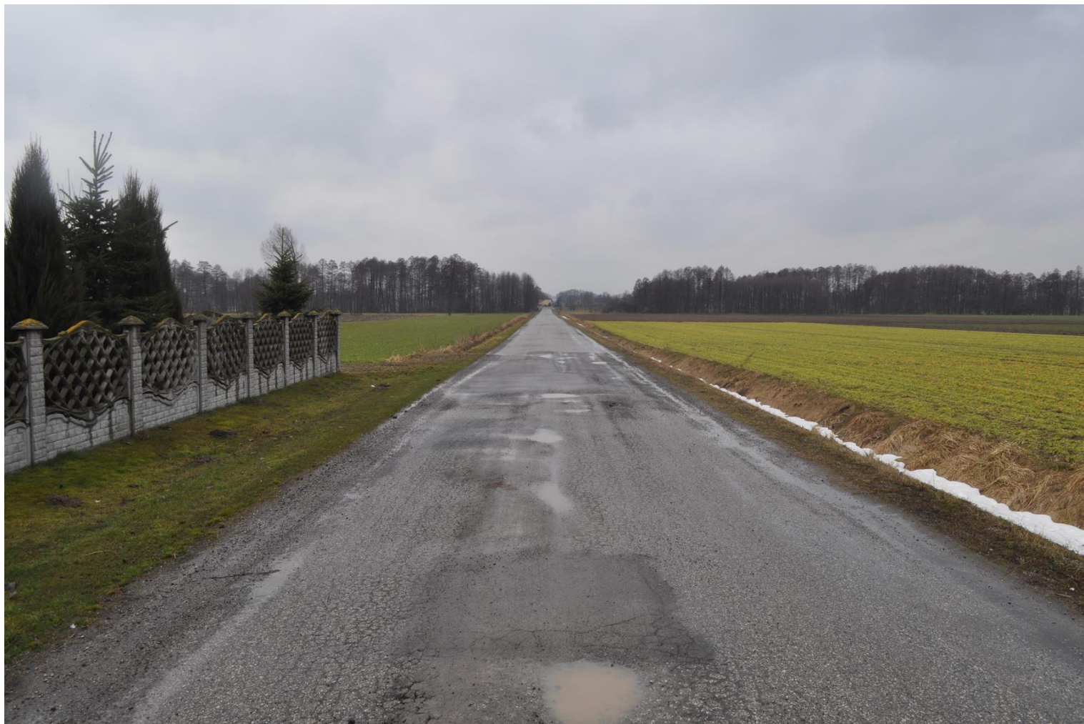
Remont drogi gminnej w miejscowości Zabłocie
