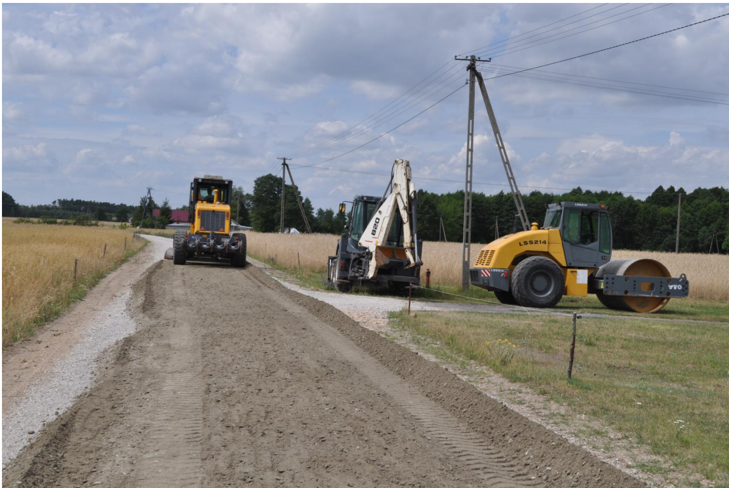
Przebudowa drogi gminnej w miejscowości Tarnówka
