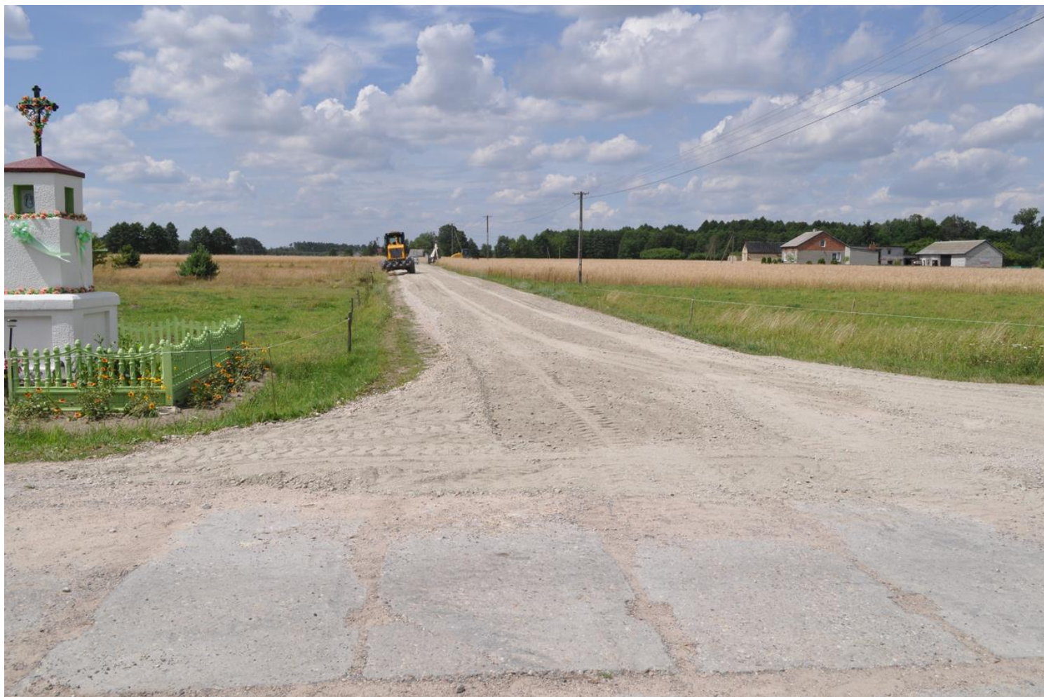
Przebudowa drogi gminnej w miejscowości Tarnówka
