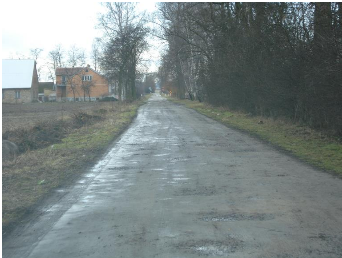
Przebudowa drogi gminnej w miejscowości Bylice-Kolonia
