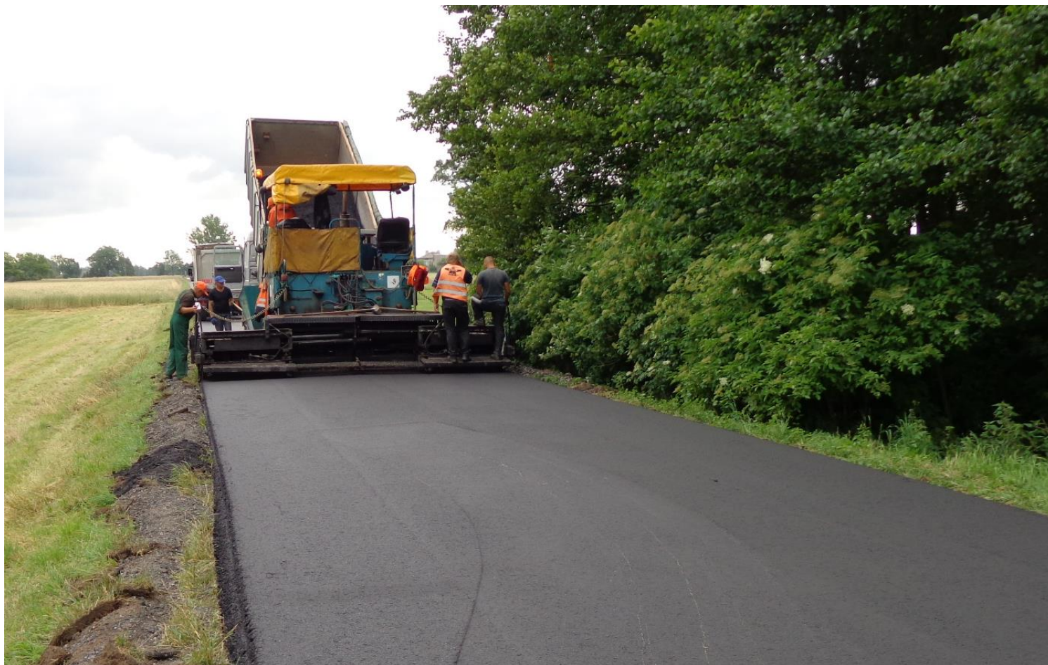
Remont drogi gminnej w miejscowości Zabłocie
