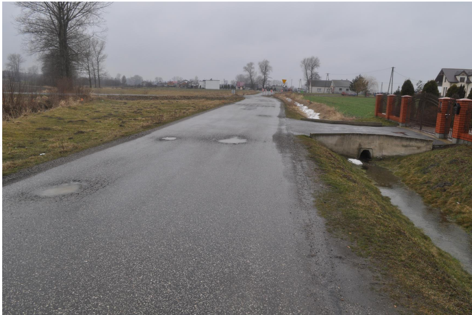
Remont drogi gminnej w miejscowości Ponętów Dolny
