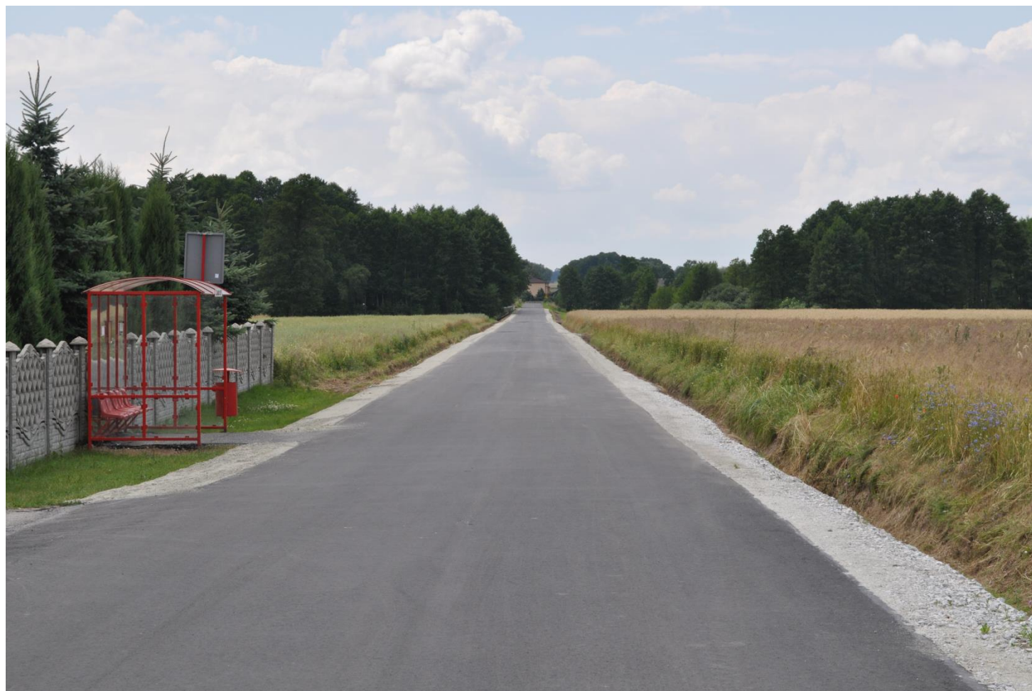
Remont drogi gminnej w miejscowości Zabłocie
