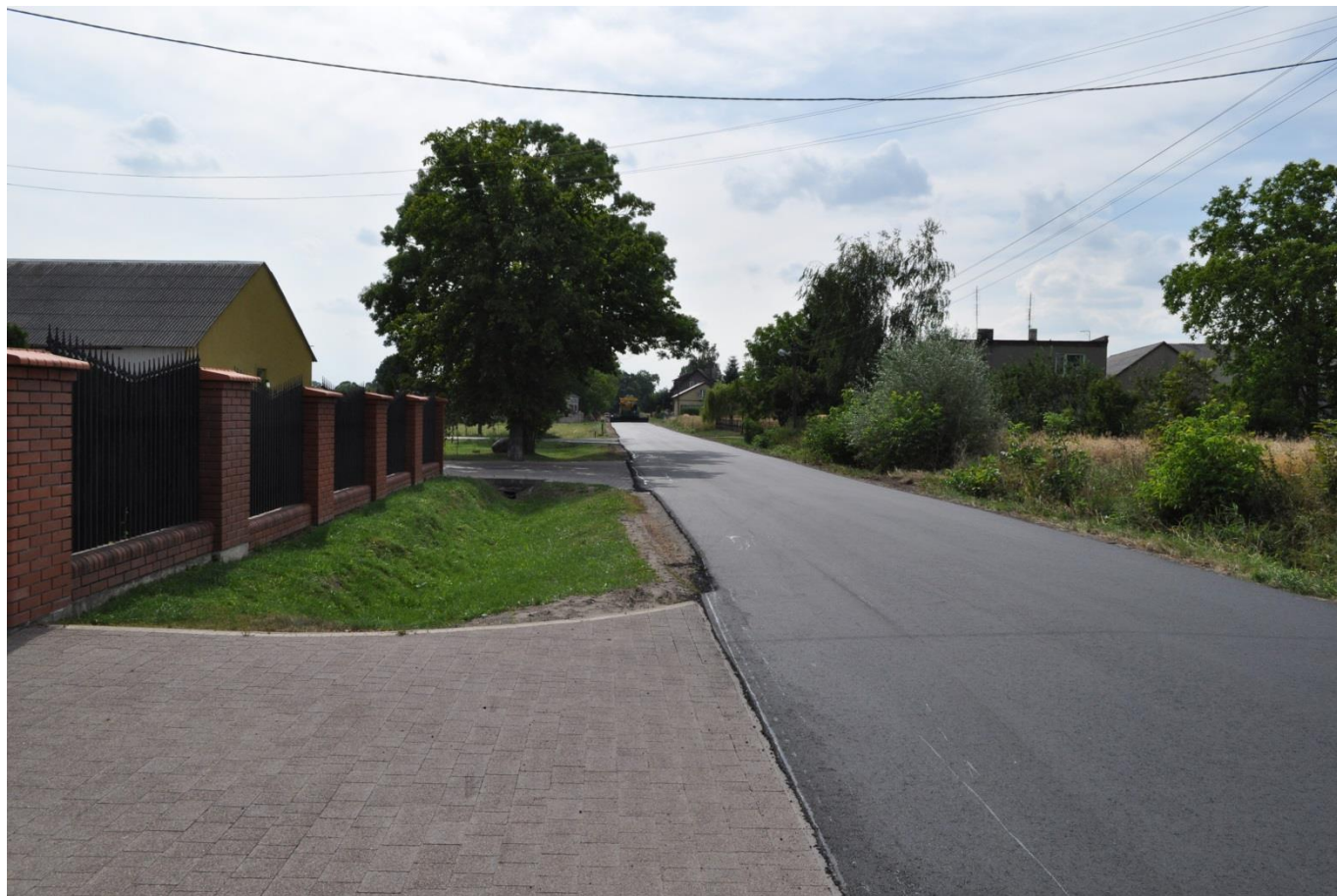
Przebudowa drogi powiatowej w miejscowości Tarnówka
