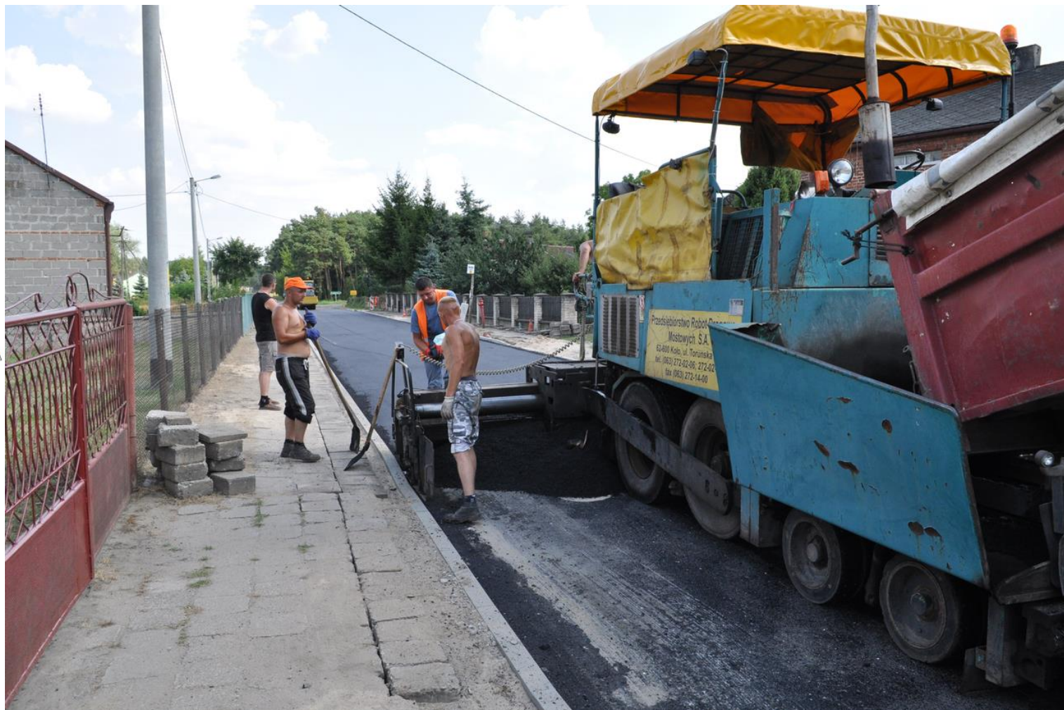
Przebudowa ulicy Leśnej
