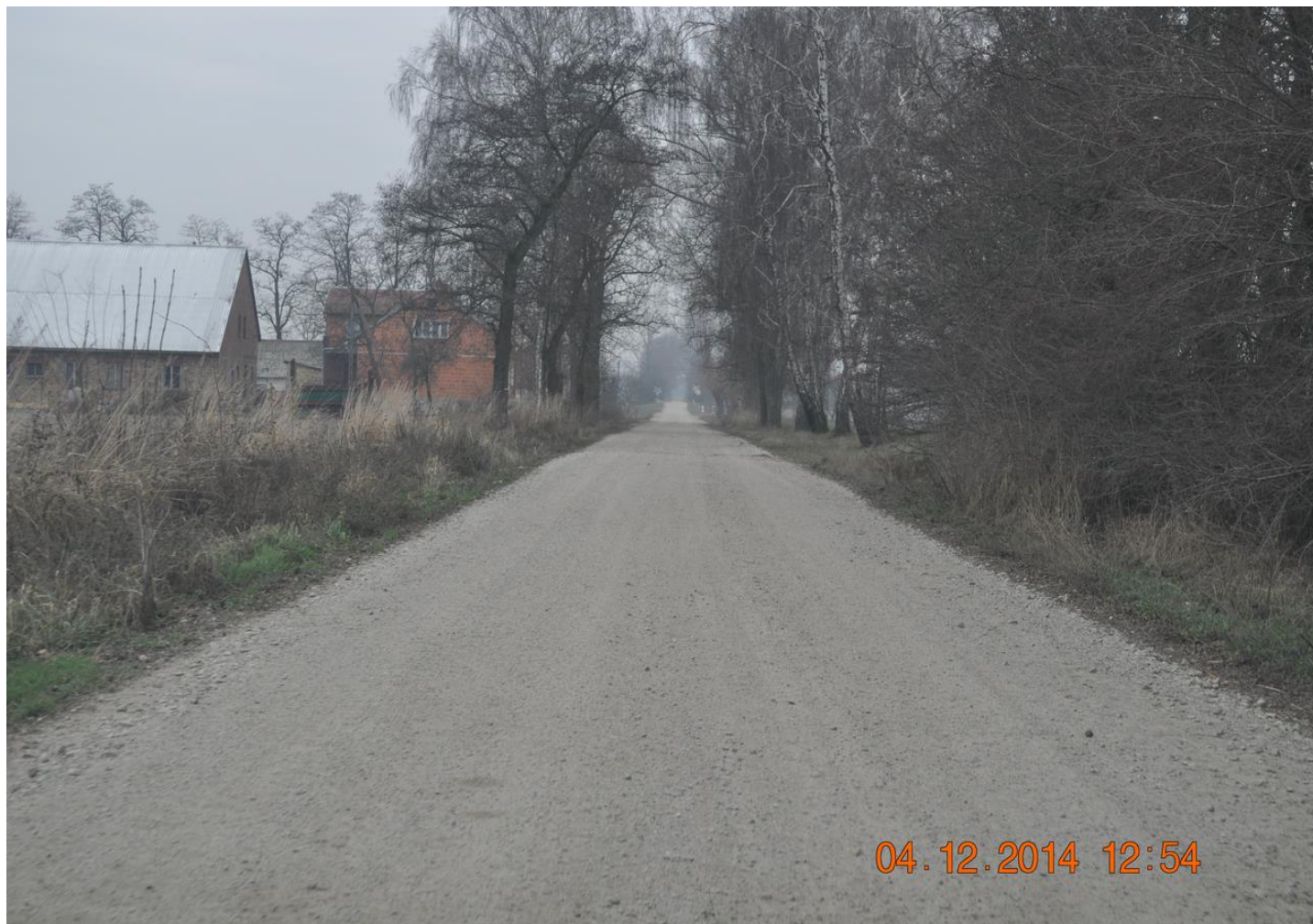
Przebudowa drogi gminnej w miejscowości Bylice-Kolonia
