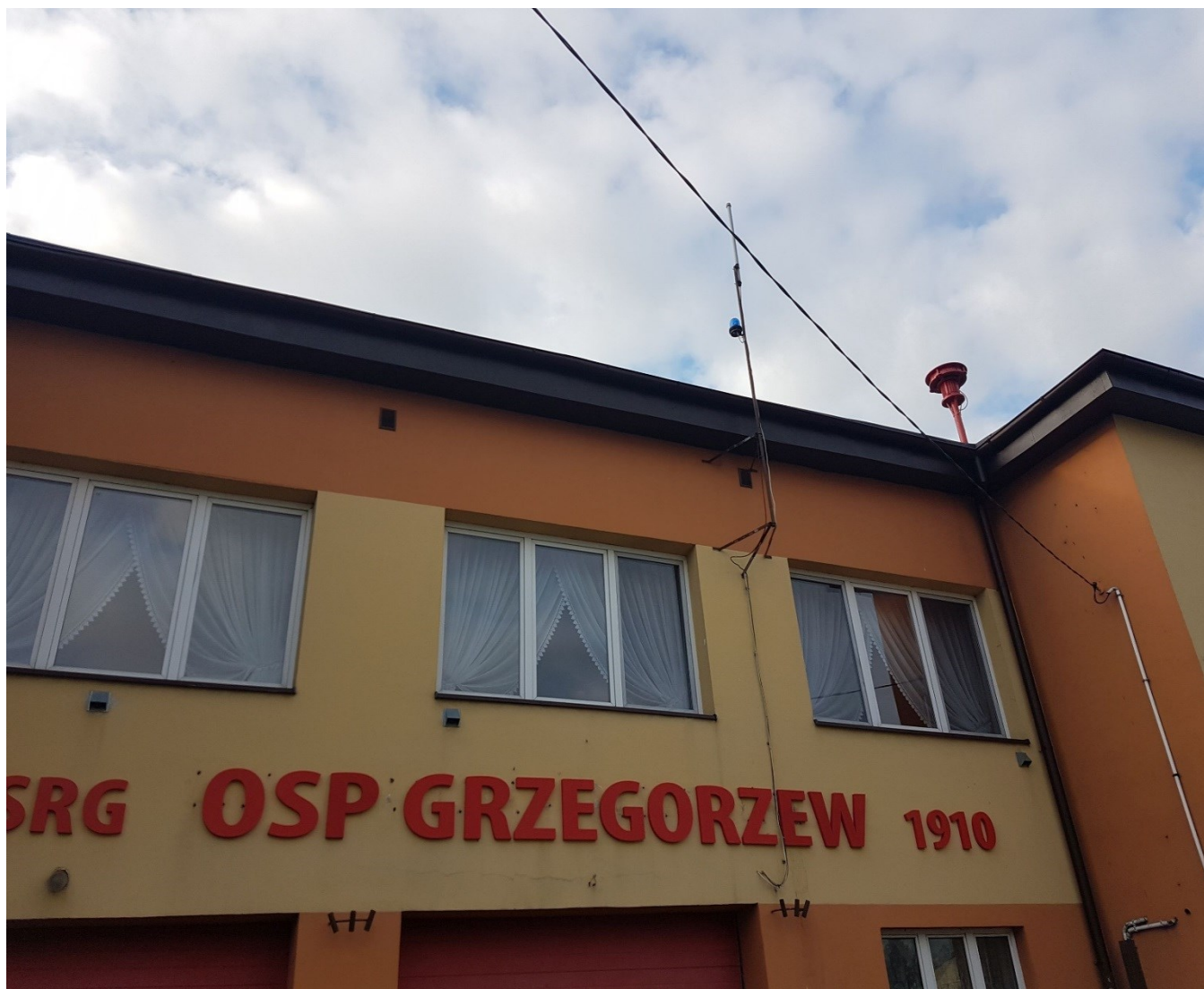
Remont dachu na remizie OSP w Grzegorzewie
