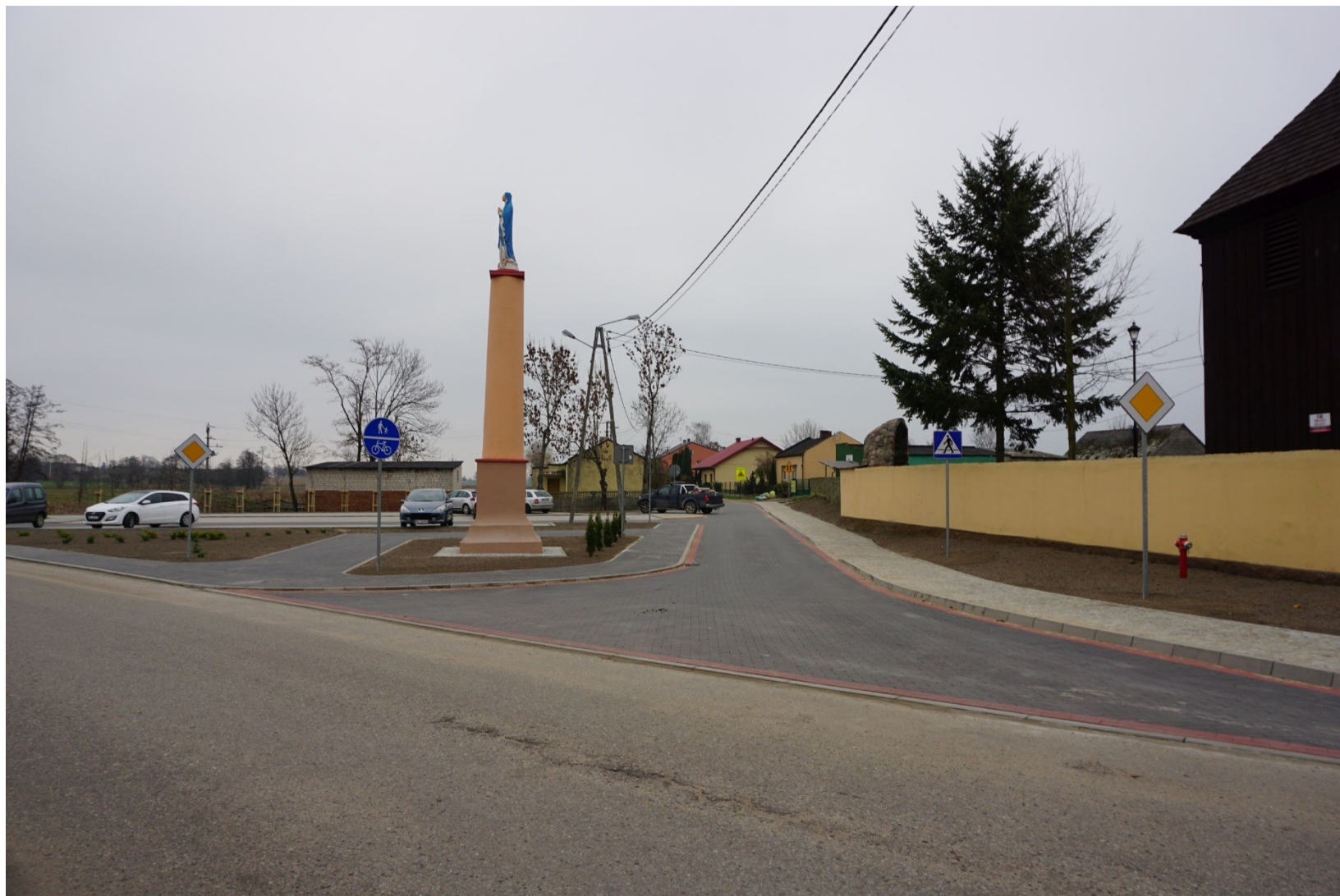
Budowa Placu Rekreacyjnego w Borysławicach Kościelnych
