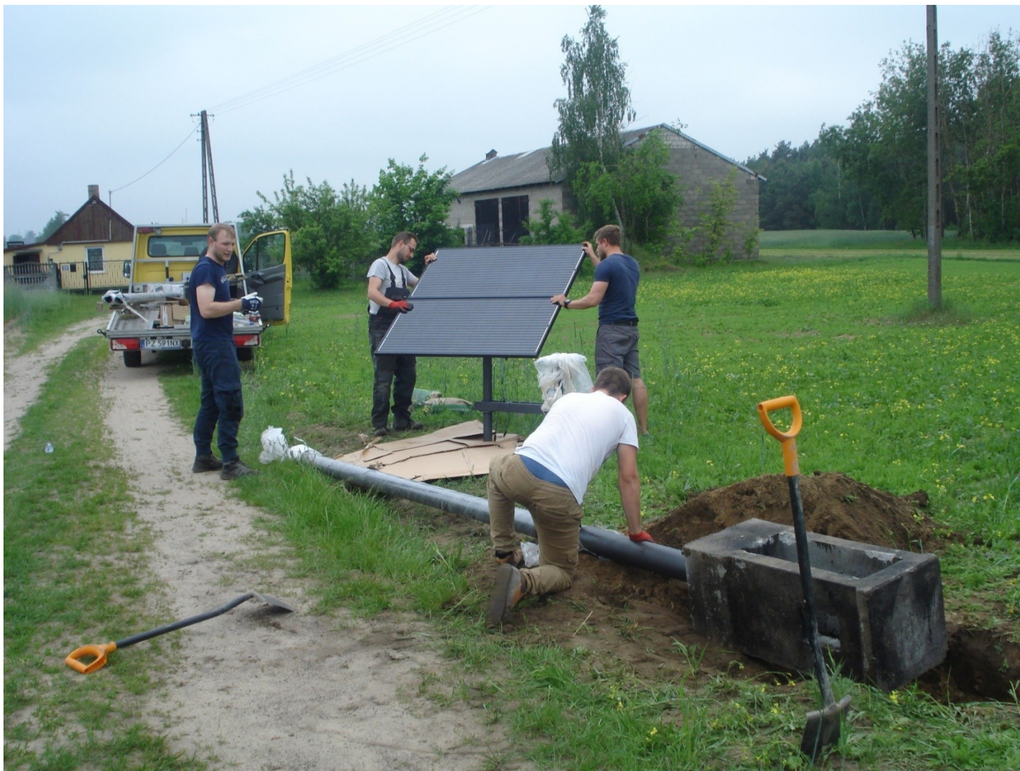
Fundusz Sołecki – Montaż Lamp Solarnych w miejscowości Barłogi
