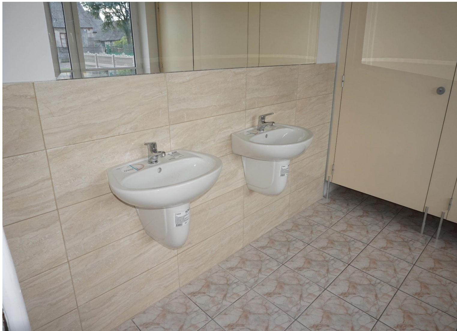
Remont Pomieszczeń Socjalnych w Świątlicy Wiejskiej w Ladorudzku
