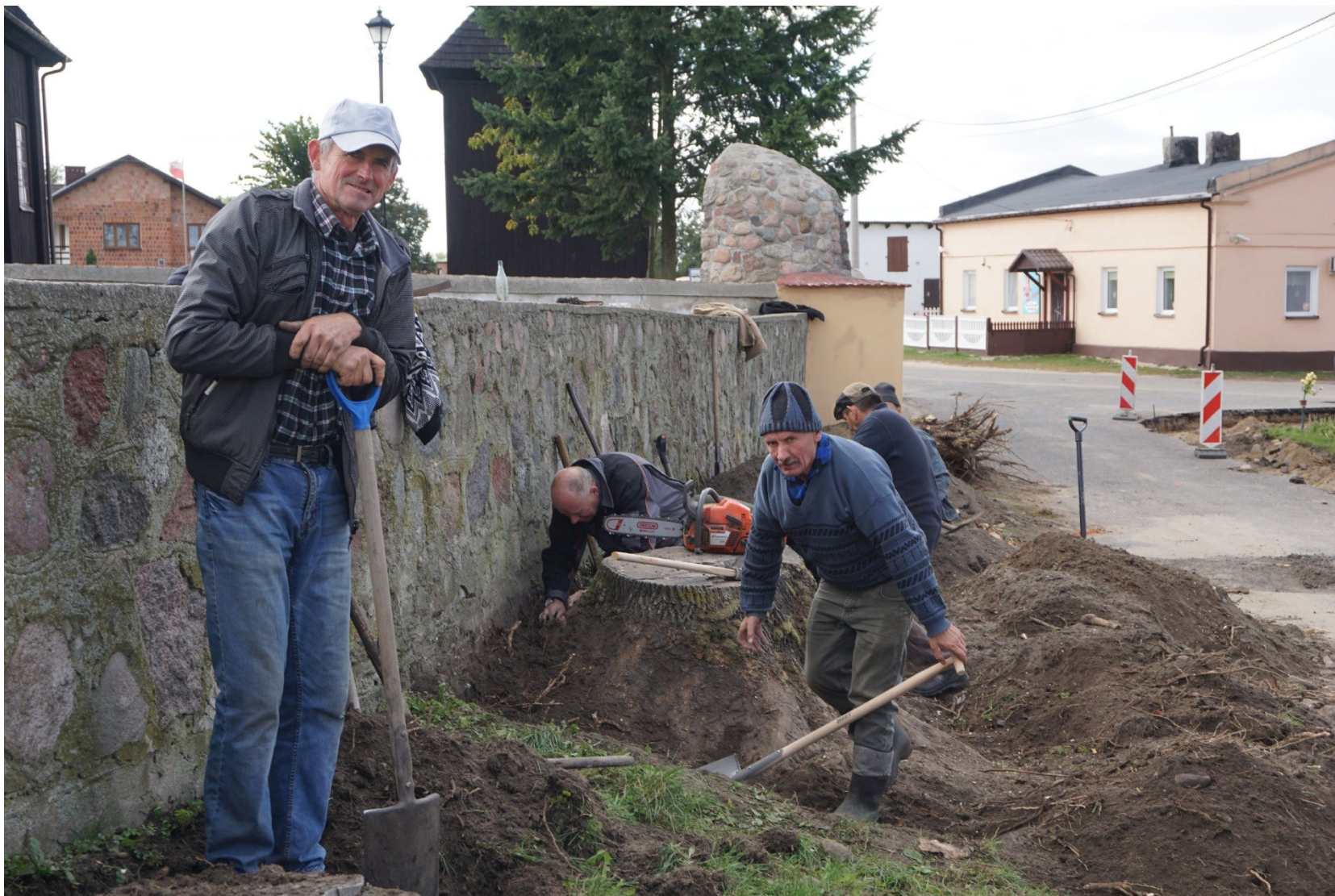
Budowa Placu Rekreacyjnego w Borysławicach Kościelnych
