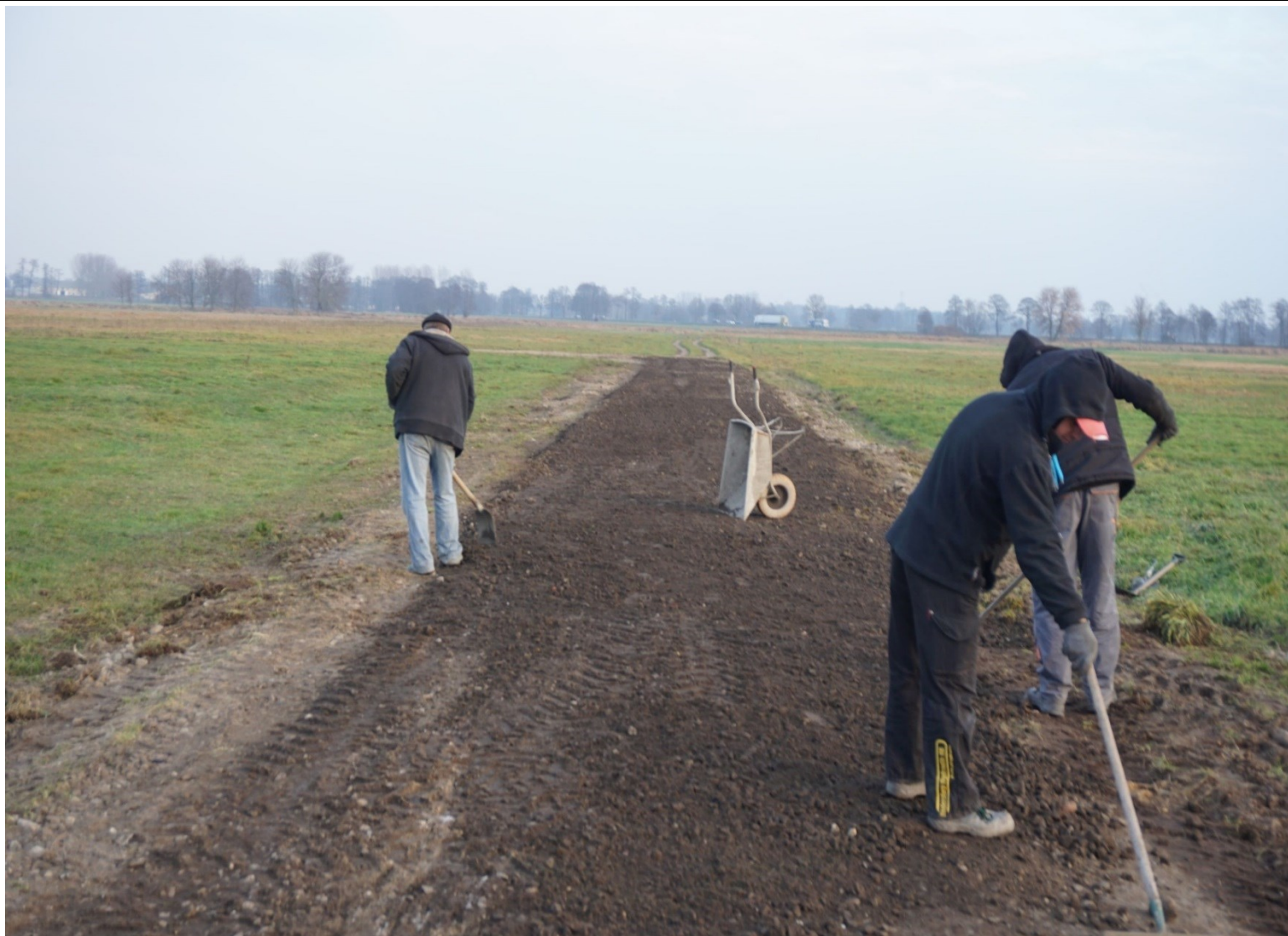
Fundusz - Sołecki Remont Drogi w Kiełczewku
