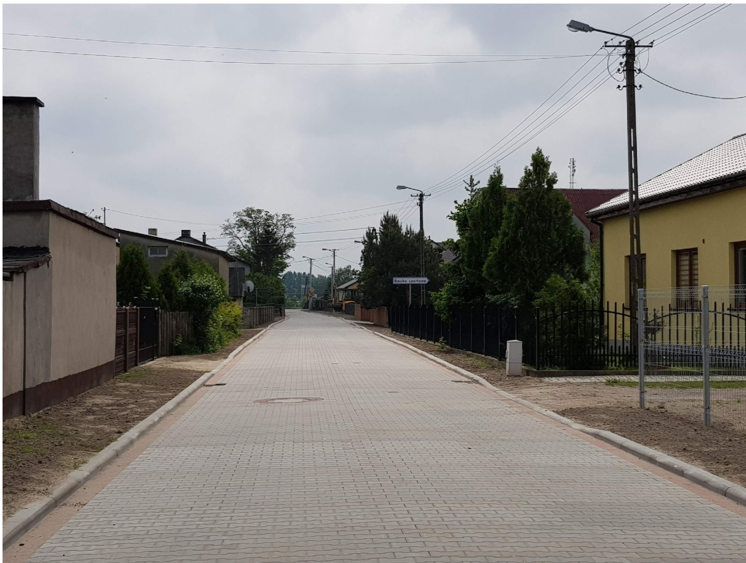
Przebudowa ulicy Słonecznej i Piaskowej w Bartłogach
