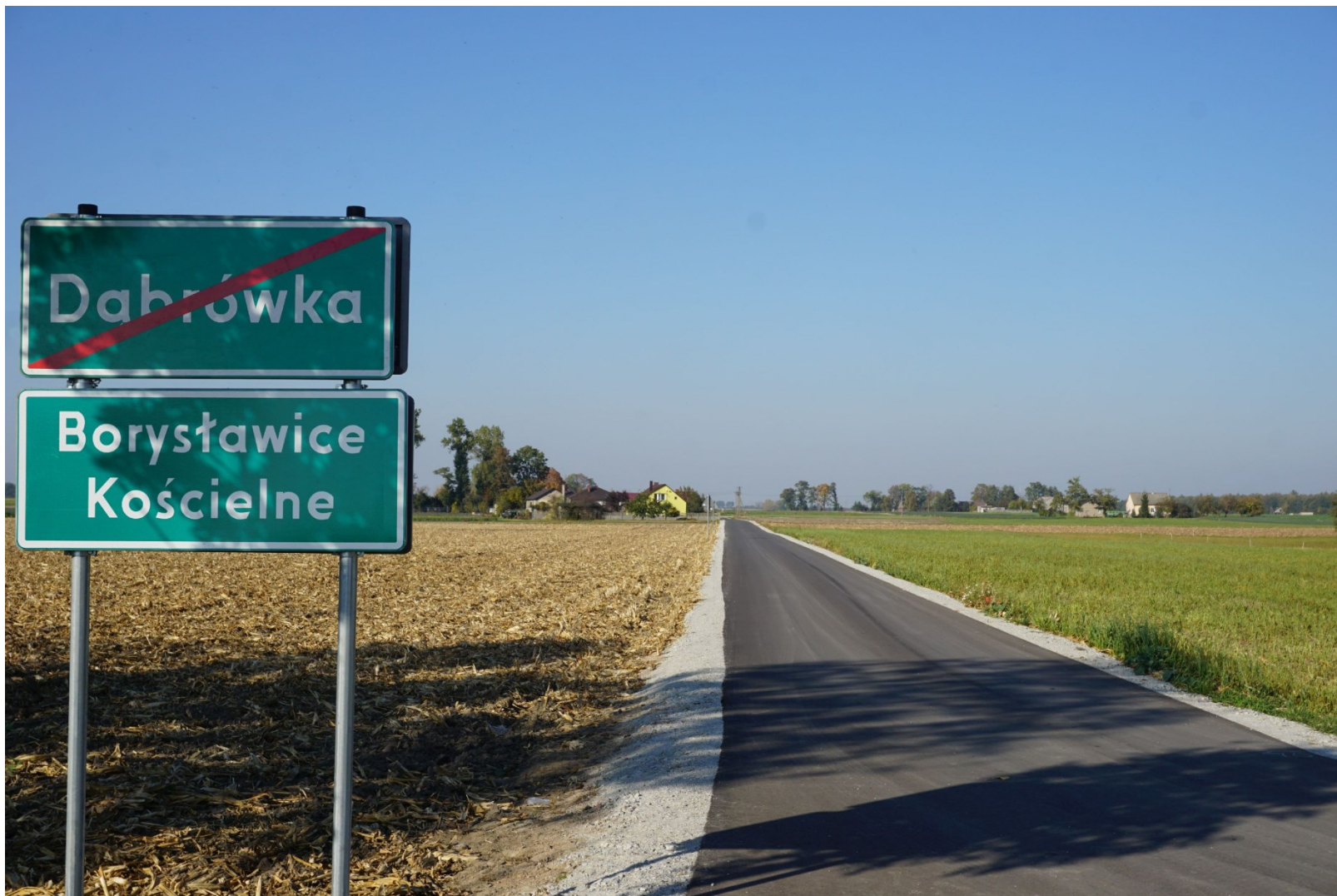
Przebudowa drogi Gminnej Borystawice Kościelne - Dąbrówka
