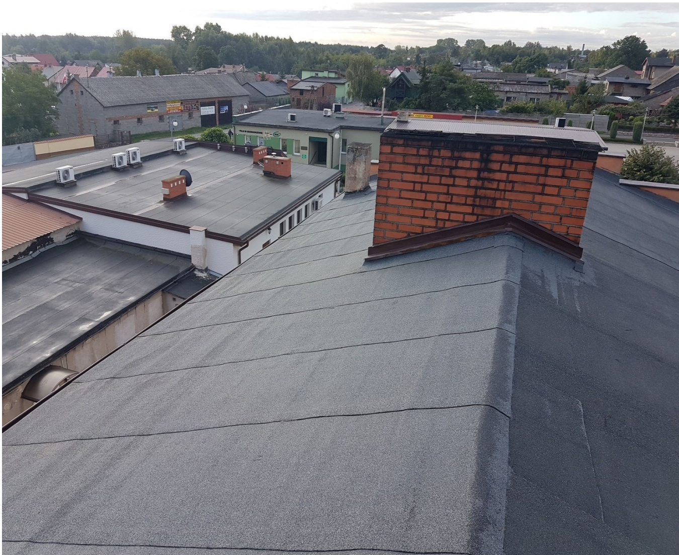
Remont dachu na remizie OSP w Grzegorzewie
