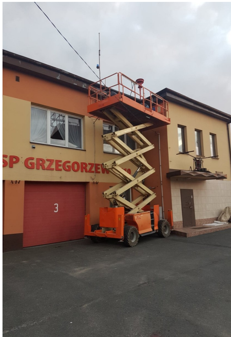
Remont dachu na remizie OSP w Grzegorzewie
