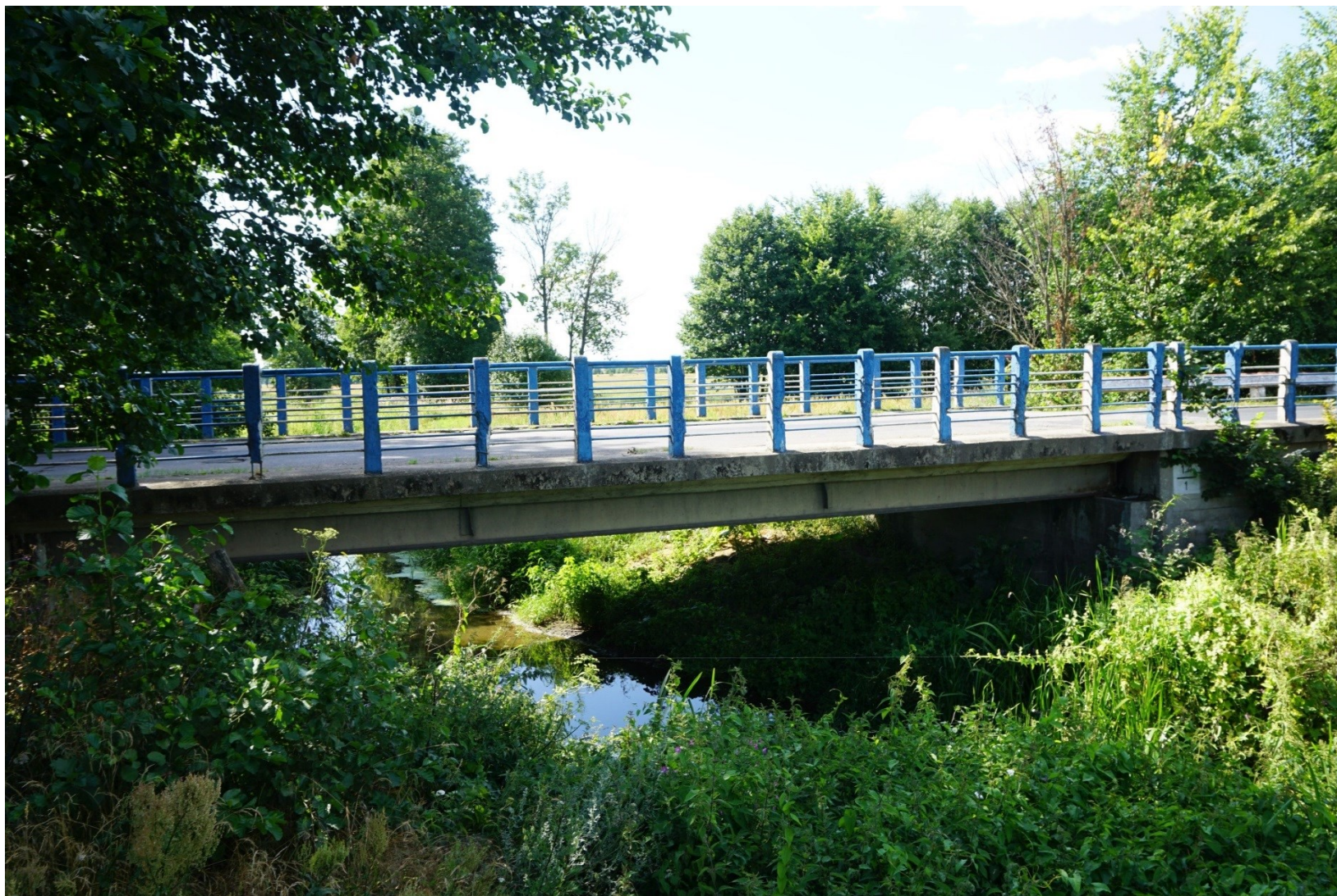
Przebudowa mostu na Rzece Rgilewce w Barłogach
