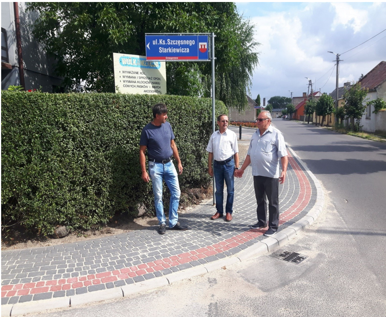
Budowa chodnika na ul. Szkolnej w Grzegorzewie
