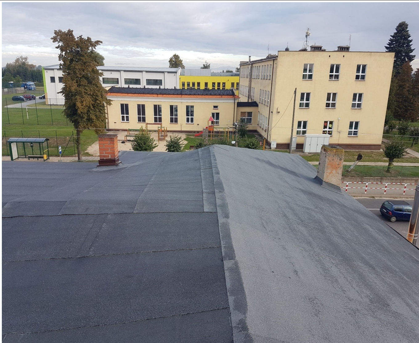
Remont dachu na remizie OSP w Grzegorzewie
