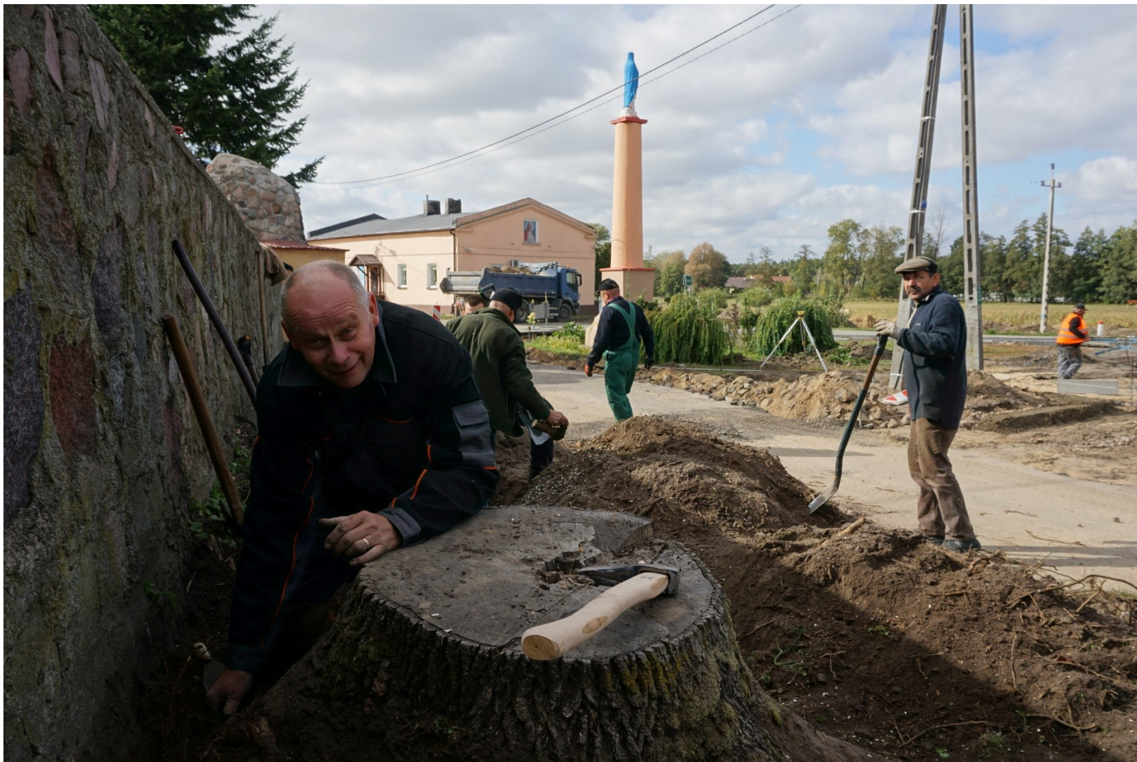
Budowa Placu Rekreacyjnego w Borysławicach Kościelnych
