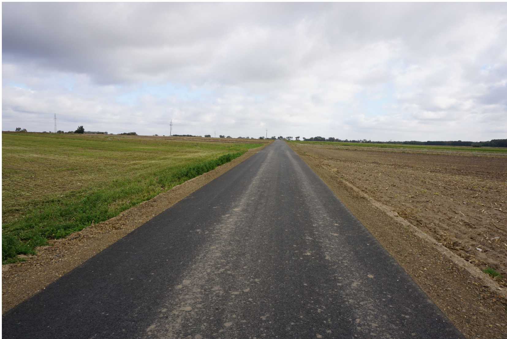
Przebudowa drogi Gminnej w Boguszyńcu
