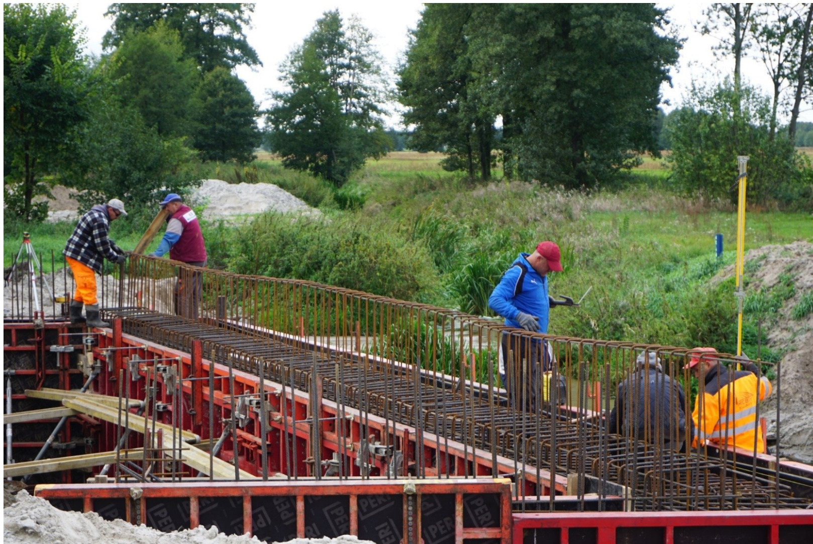
Budowa mostu na Rzece Rgilewce w Barłogach
