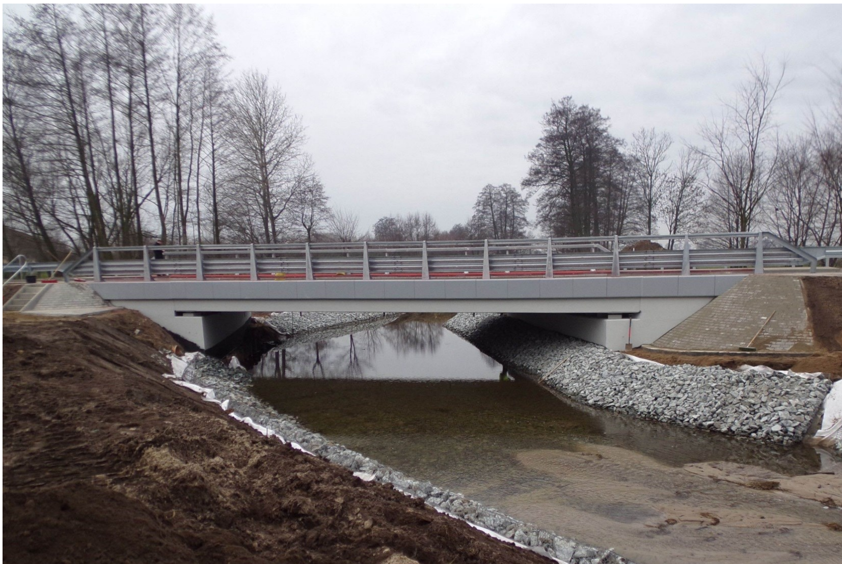
Budowa mostu na Rzece Rgilewce w Barłogach
