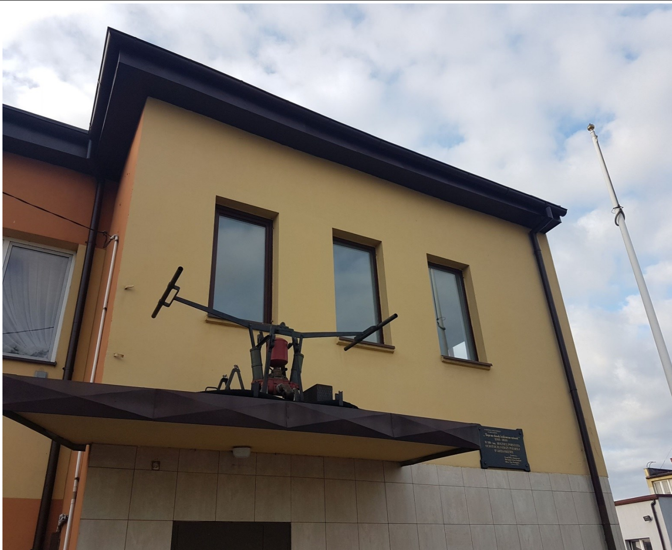
Remont dachu na remizie OSP w Grzegorzewie
