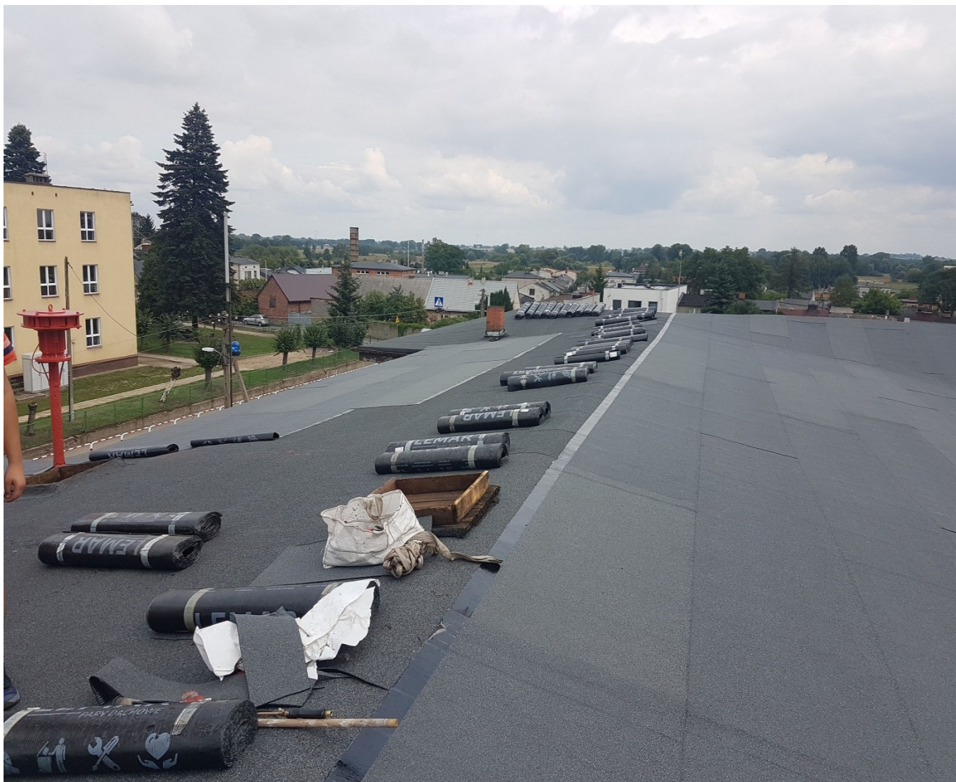
Remont dachu na remizie OSP w Grzegorzewie
