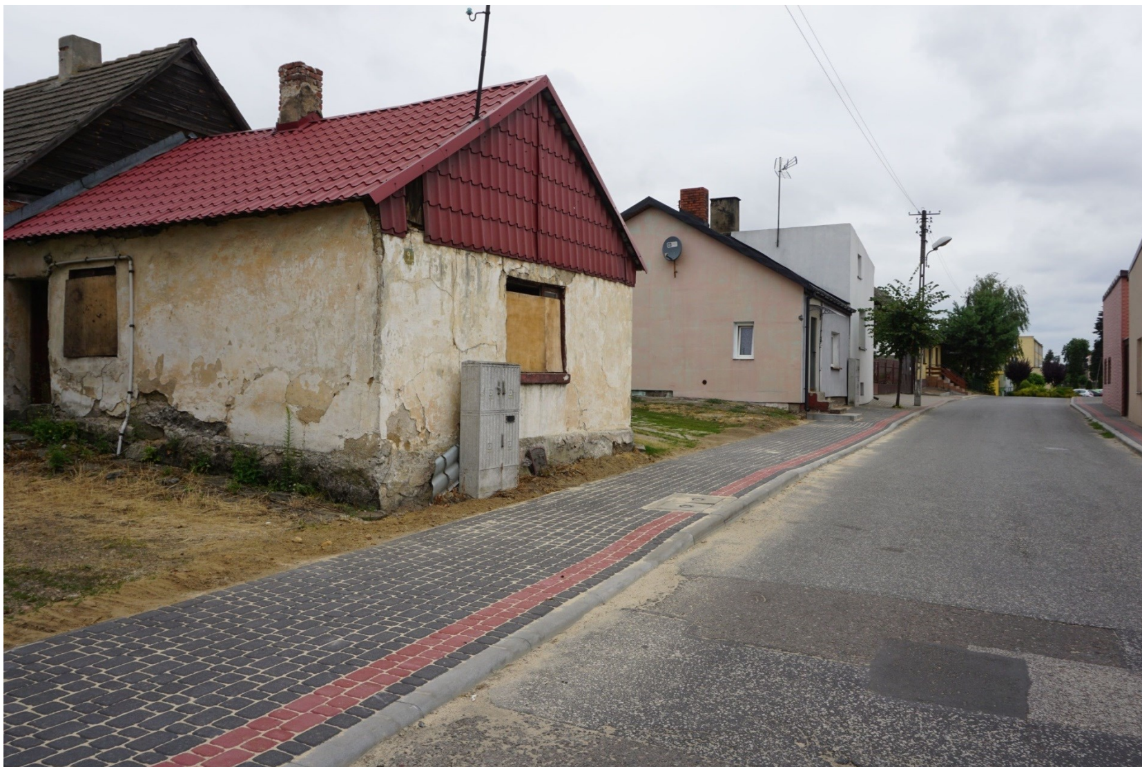
Budowa chodnika na ul. Szkolnej w Grzegorzewie
