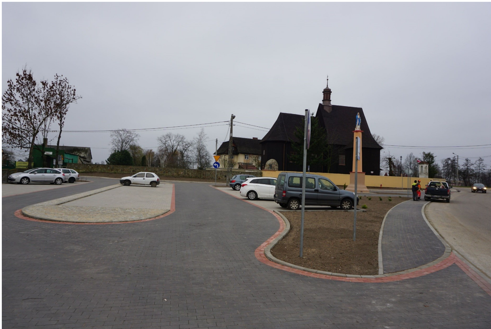
Budowa Placu Rekreacyjnego w Borysławicach Kościelnych
