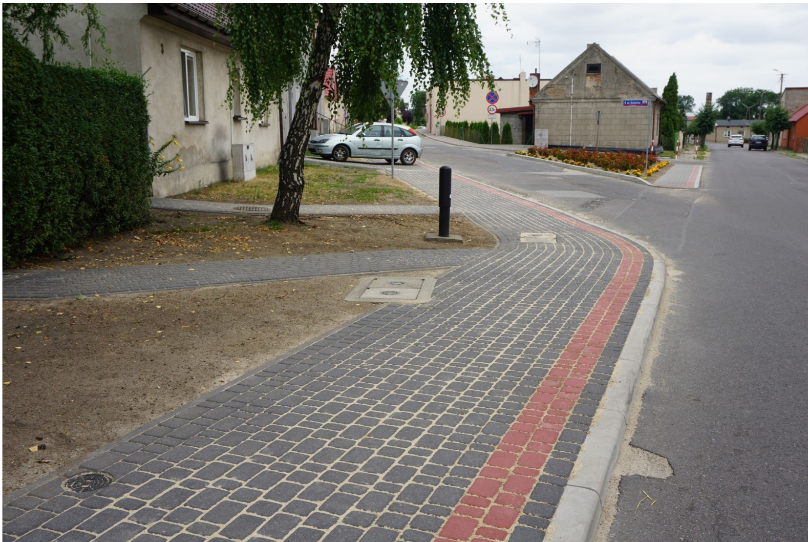
Budowa chodnika na ul. Szkolnej w Grzegorzewie
