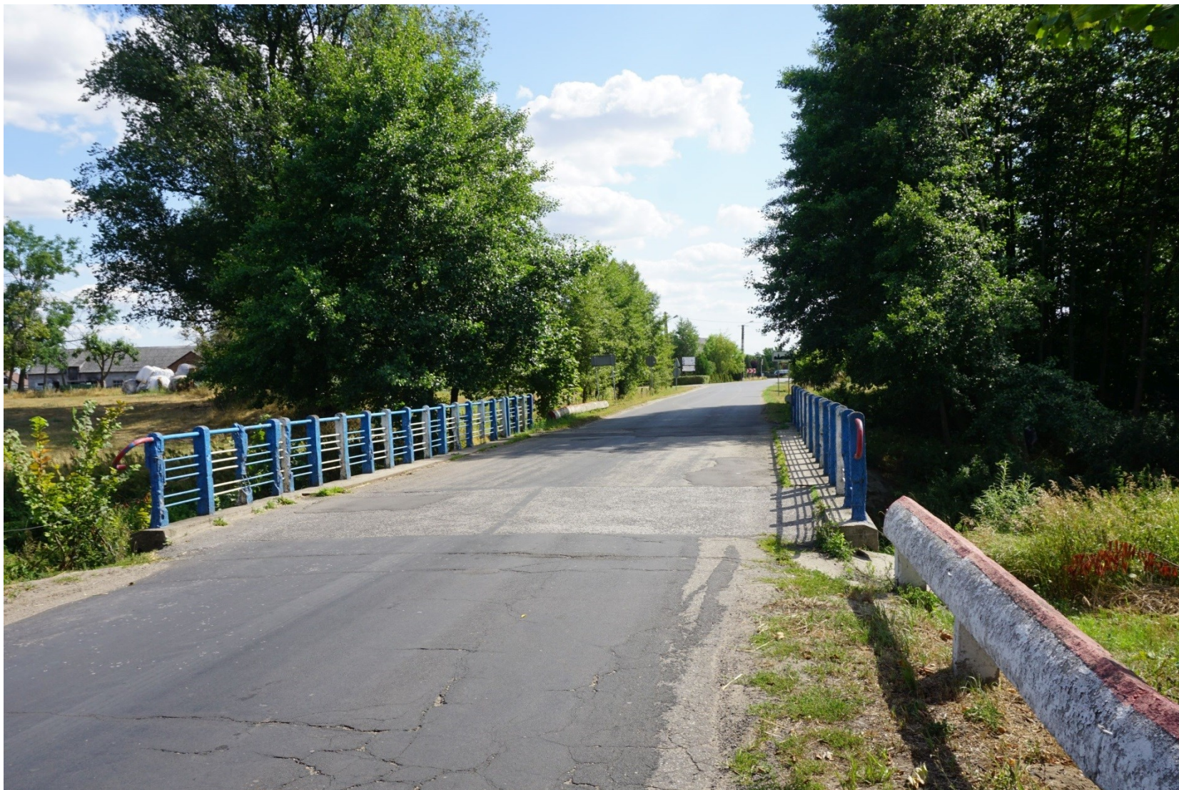
Przebudowa mostu na Rzece Rgilewce w Barłogach
