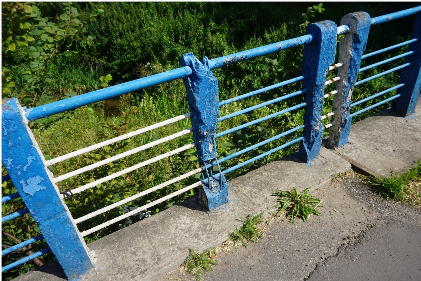
Przebudowa mostu na Rzece Rgilewce w Barłogach
