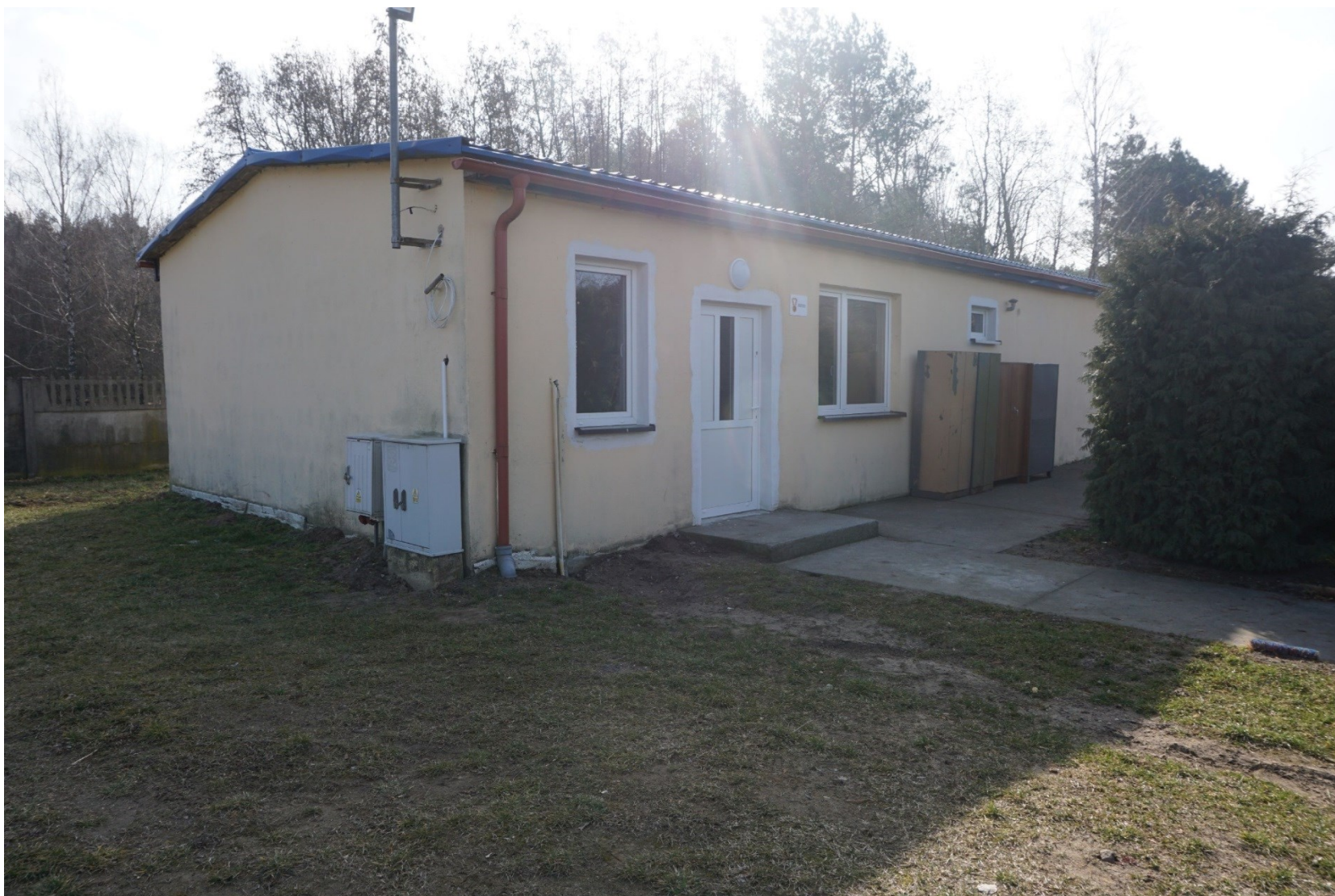
„Szatnia na Medal” Remont budynku na stadionie w Grzegorzewie
