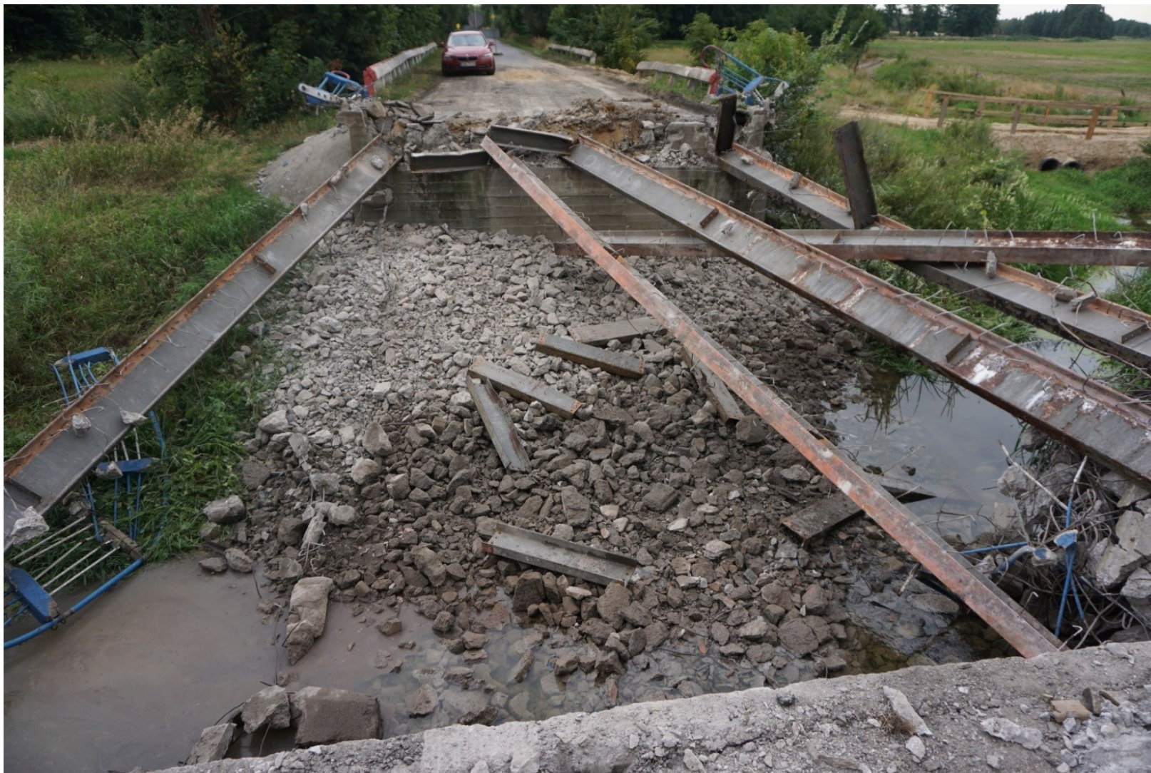
Budowa mostu na Rzece Rgilewce w Barłogach
