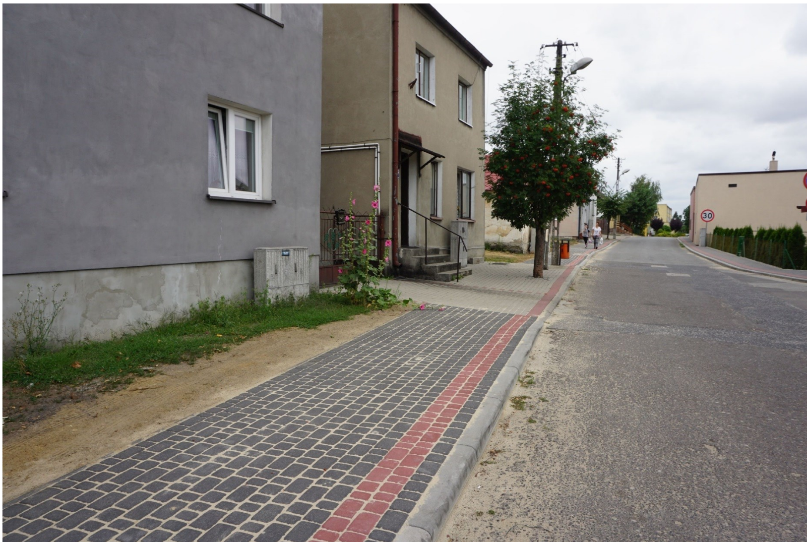
Budowa chodnika na ul. Szkolnej w Grzegorzewie
