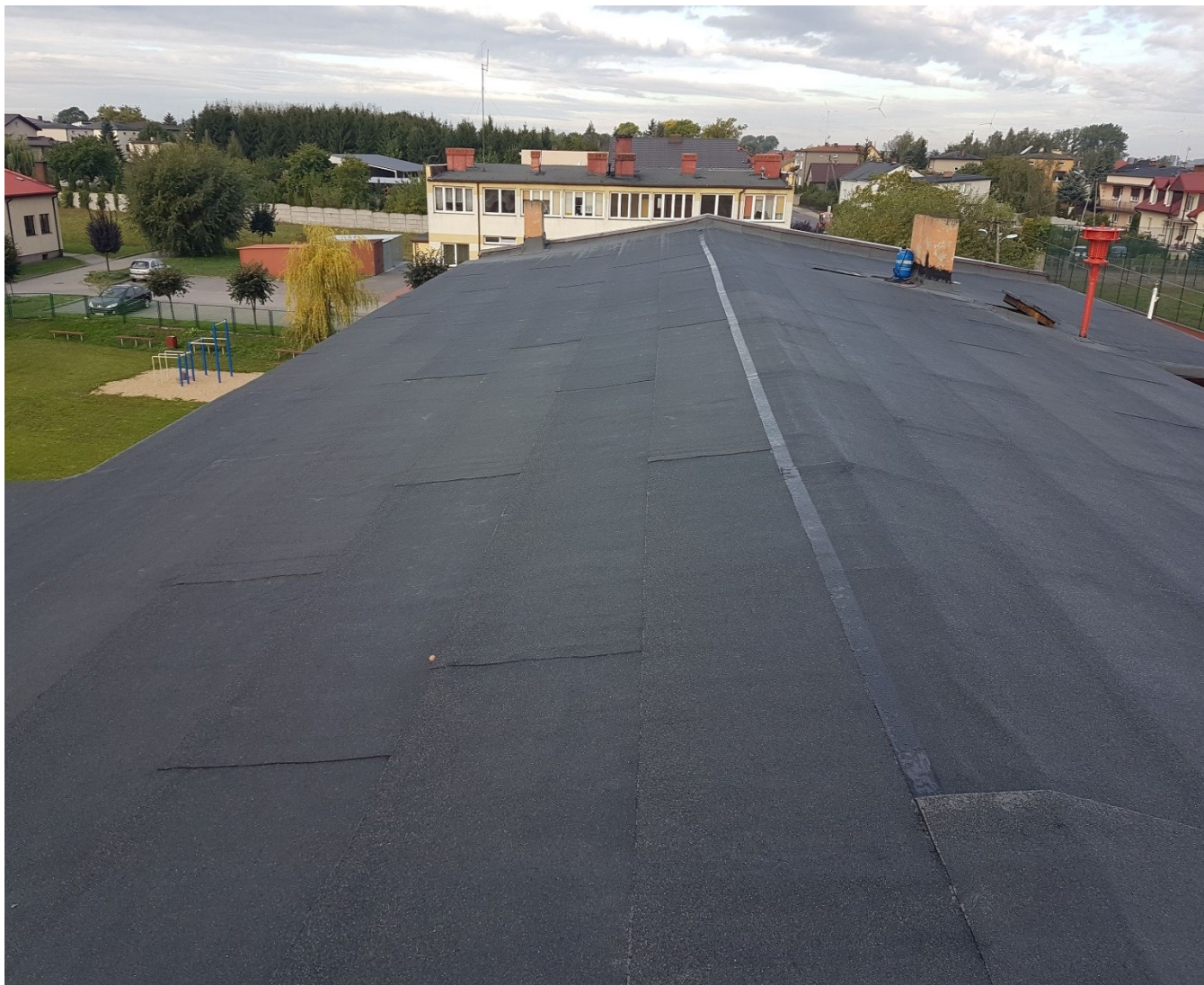
Remont dachu na remizie OSP w Grzegorzewie
