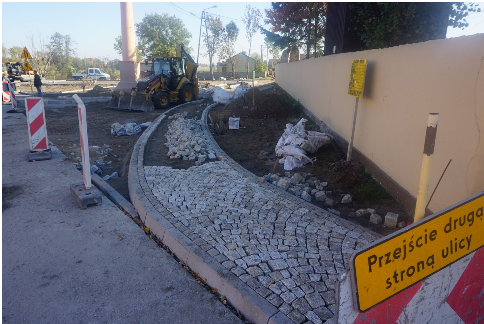
Budowa Placu Rekreacyjnego w Borysławicach Kościelnych
