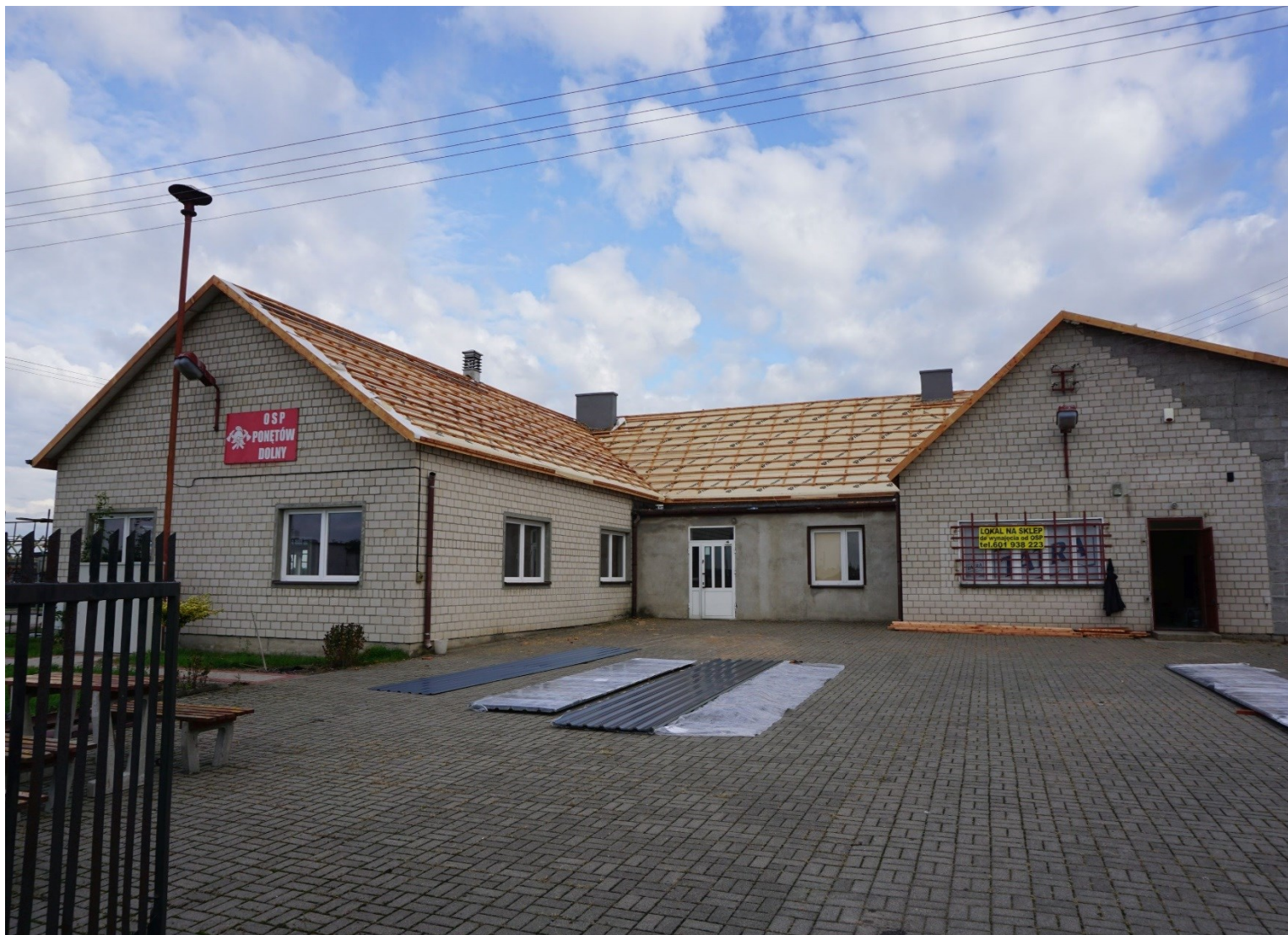
Remont dachu na remizie OSP w Ponętowie Dolnym
