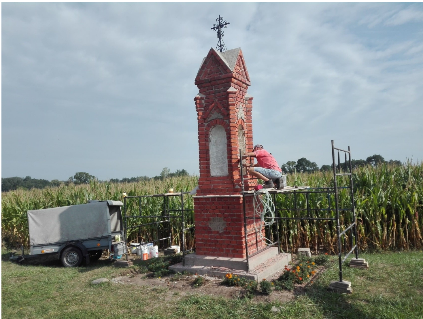
Fundusz Sołecki - Remont Kapliczki w Boguszyńcu
