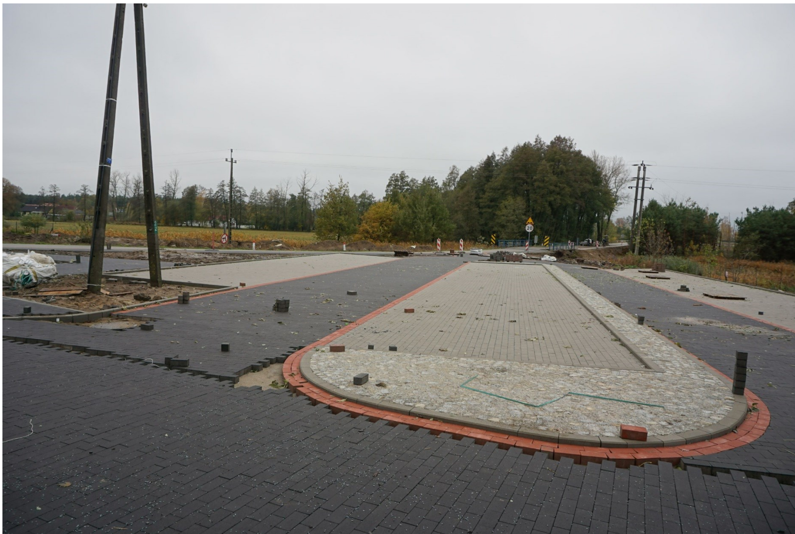
Budowa Placu Rekreacyjnego w Borysławicach Kościelnych
