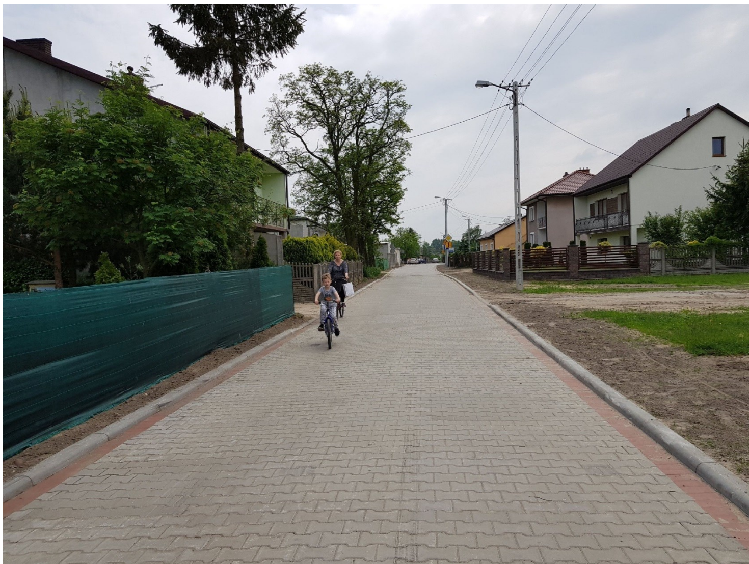
Przebudowa ulicy Słonecznej i Piaskowej w Bartogach
