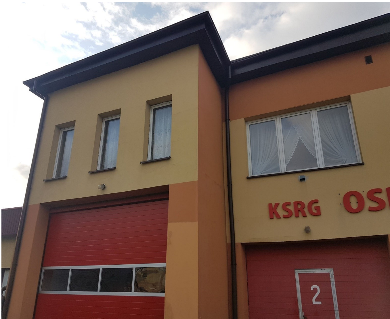
Remont dachu na remizie OSP w Grzegorzewie
